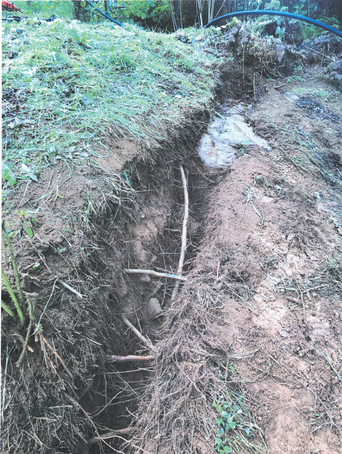
Grøft sett mot sørvest. Synlig fjell
