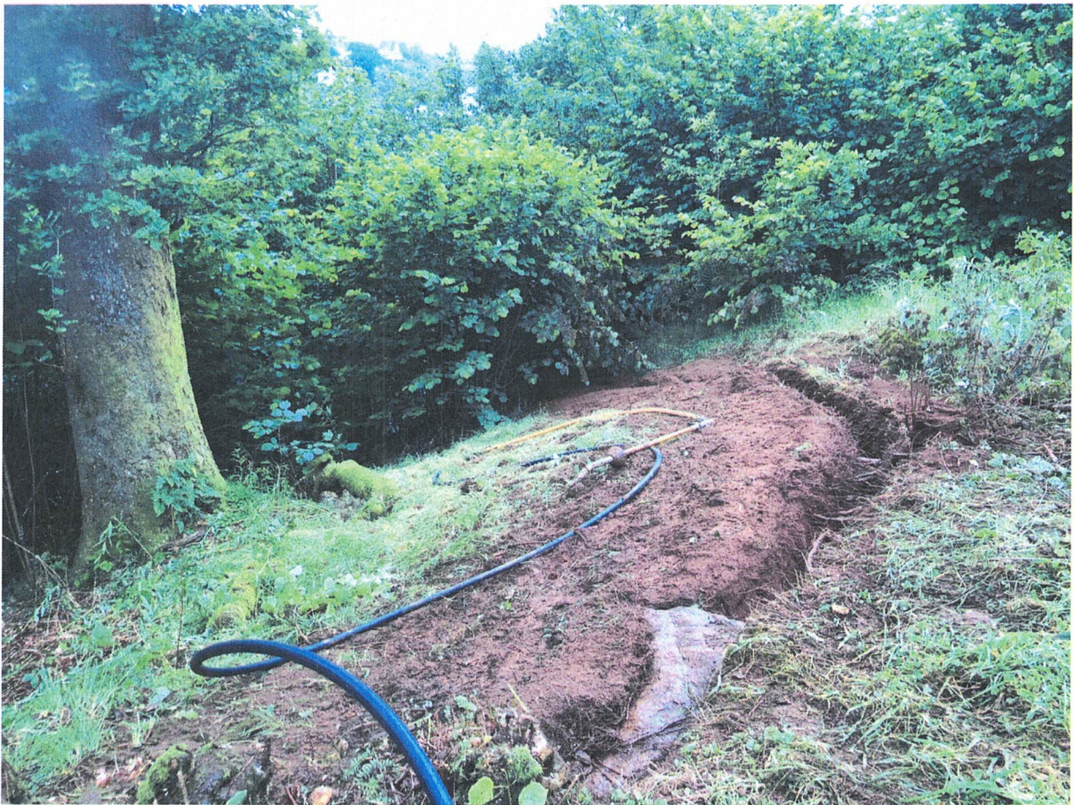
Grøft i avstand 5 meter fra stammen
