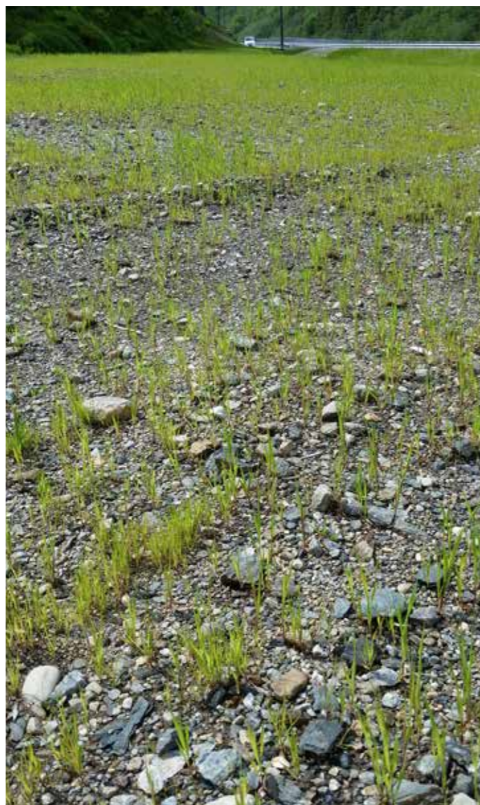
EKSEMPEL PÅ TOPPDEKKE SOM IKKE ER AKSEPTABELT
