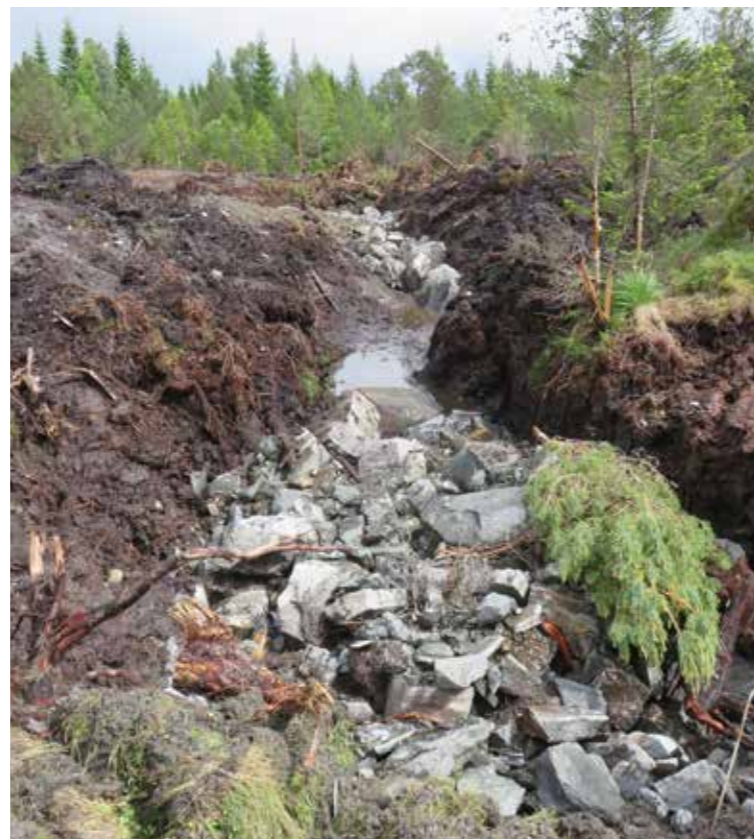
SPRENGSTEIN KAN BRUKAST I KANALAR
