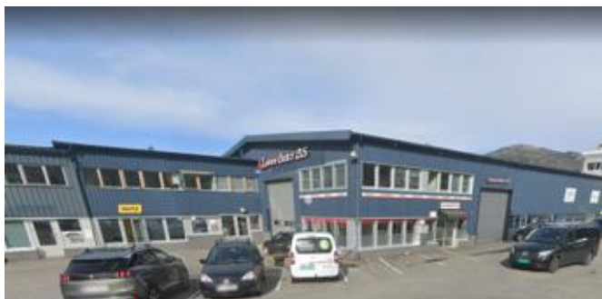
Figur 3: Kanalveien 48 (Kilde: Google street view)
