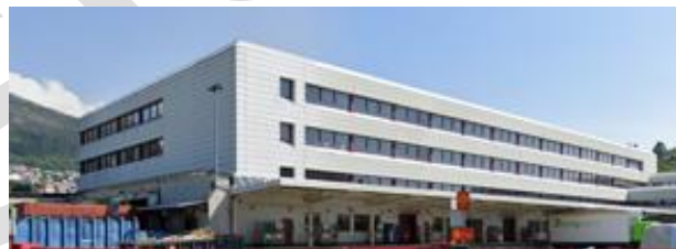
Figur 6: Bergen postterminal sett fra Kanalveien (Kilde: Google street view)
