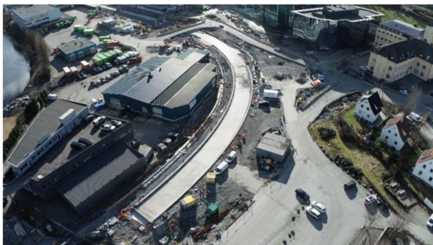
Figur 7: Bygging av bybanen i planområdets nordvestre kant (Kilde: Bergen kommunes nettside om Mindebyen https://www.bergen.kommune.no/hvaskjer/tema/mindemyren )
