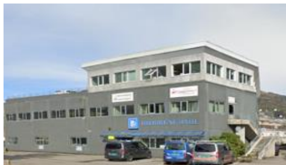
Figur 4: Kanalveien 46 (Kilde: Google street view)
