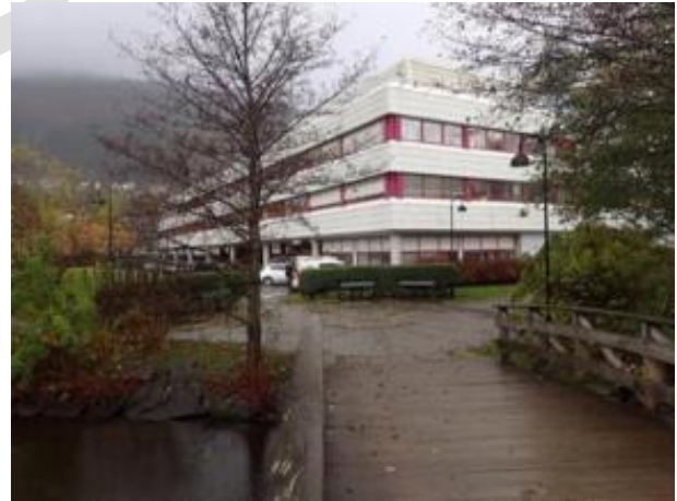
Figur 15: Gangbru ved postterminalen (Kilde: Rambøll)
