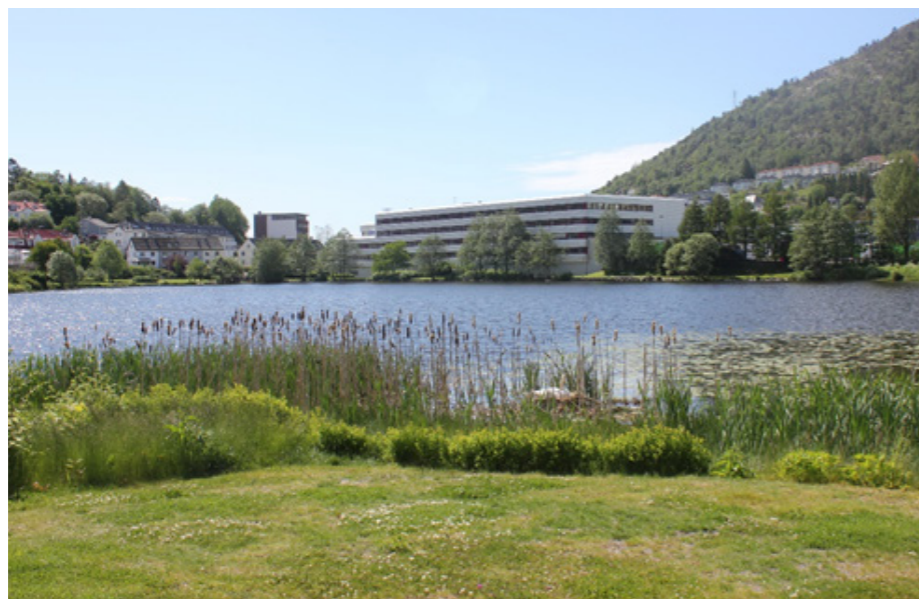
Figur 11: : Postterminalen sett fra nord mot sør.
