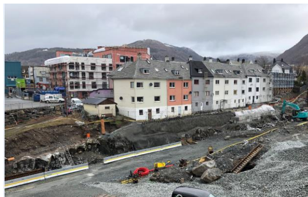
Figur 4-5 Krohnhaugen 2-14 med Fabrikkgaten 7A i bakgrunnen, sett mot nordøst.
