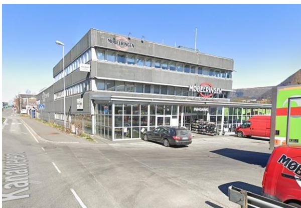
Figur 5-9 Kanalveien 50 før riving, april 2019 (Google streetview).
