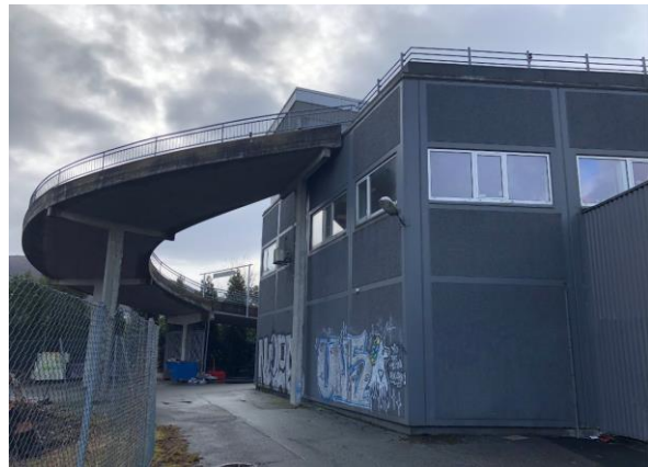
Figur 5-6 Rampen på sør- og østsiden av Kanalveien 46 sett mot sør.
