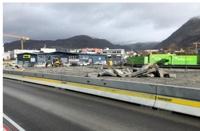
Figur 5-10 Situasjon etter bygget i Kanalveien 50 er revet.
