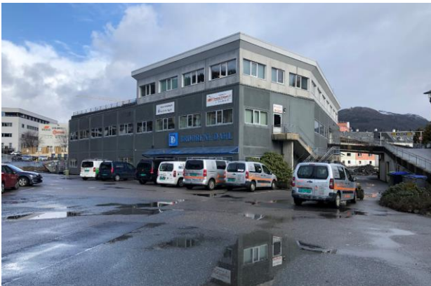
Figur 5-5 Kanalveien 46 sett mot nordøst.
