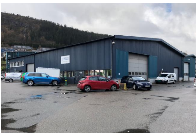
Figur 5-3 Kanalveien 48 sett mot nordvest.
