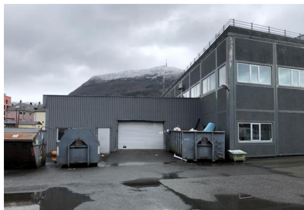
Figur 5-8 Tilbygg på nordsiden av Kanalveien 46 sett mot øst.
