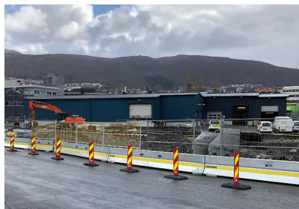
Figur 5-4 Kanalveien 48 sett mot sør.
