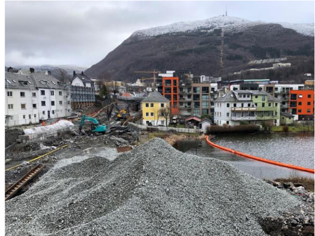
Figur 5-12 Området på nordsiden av Solheimsvannet er tatt i bruk som anlegg- og riggområde. Inndalsveien 5B, 7C og 7D i bakgrunnen.
