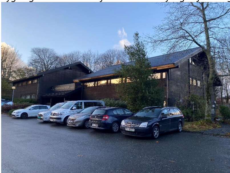
Figur 11. Byggets fasade mot øst. Foto: Grieg Arkitekter
