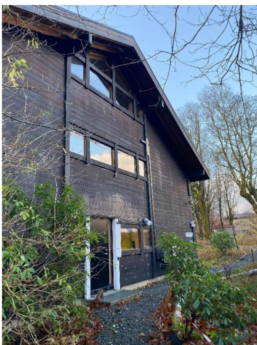
Figur 13. Fasade mot nord.
