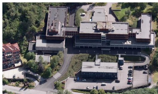
Figur 24. Næringsbygg sørøst for planområdet.
