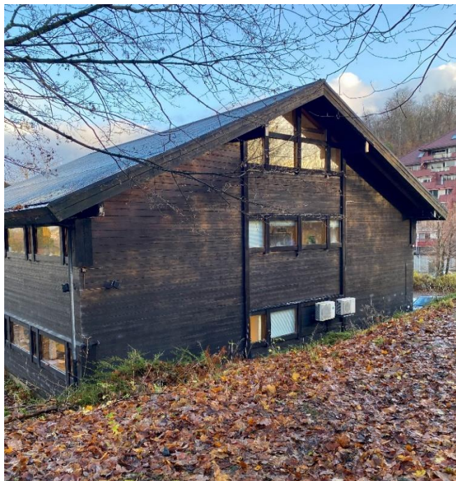
Figur 14. Fasade mot sør.
