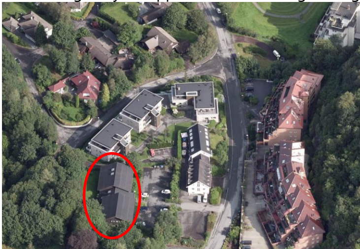
Figur 23. Skråfoto av bygningsmiljøet rundt Fantoftvegen 44.
