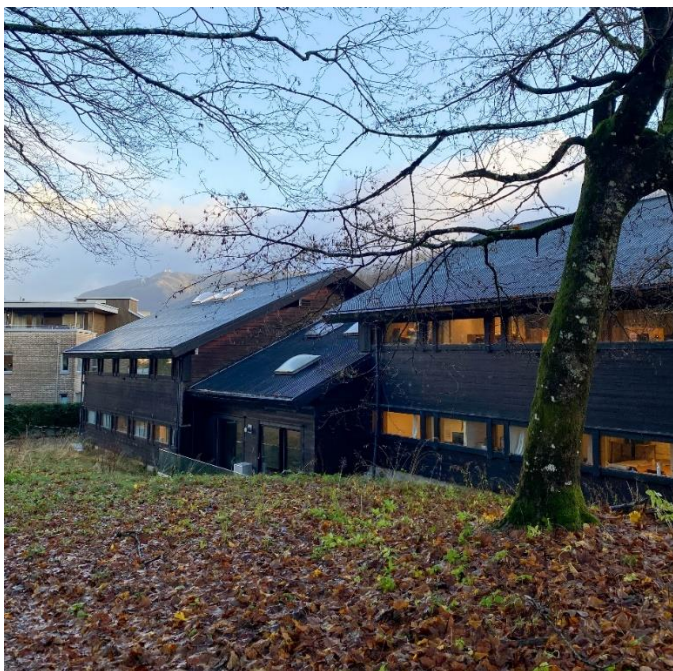
Figur 15. Fasade mot vest. Foto: Grieg Arkitekter
