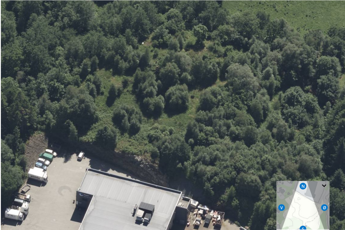
Figur 2. Espehaugen 29 nederst i bildet. Legg merke til eksisterende fjellskjæring som viser at fjellet ligger tett opp i dagen.
