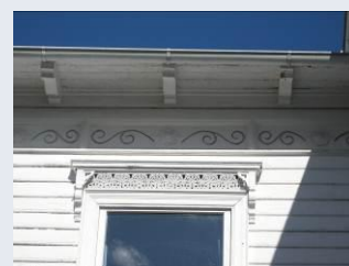
Eksempel på særegne bygningsmessige detaljer
