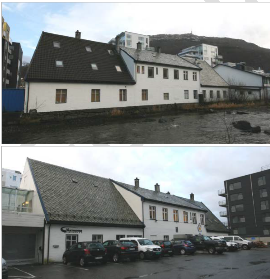
Figur 46: Bygg i BKB1 vil bevares i størst mulig grad slik det er i dag utvendig. Øverst: Byggets fasade mot Møllendalselven. Nederst: Byggets fasade mot fremtidig gatetun (f_SGT1). Foto: Opus Bergen AS.
