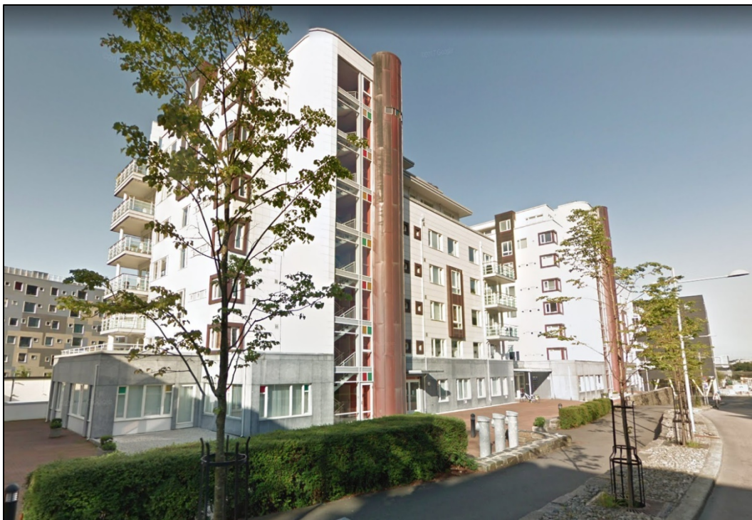
Figur 12: Eksisterende blokkbebyggelse. Møllendalsveien 65. Kilde: google maps, streetview
