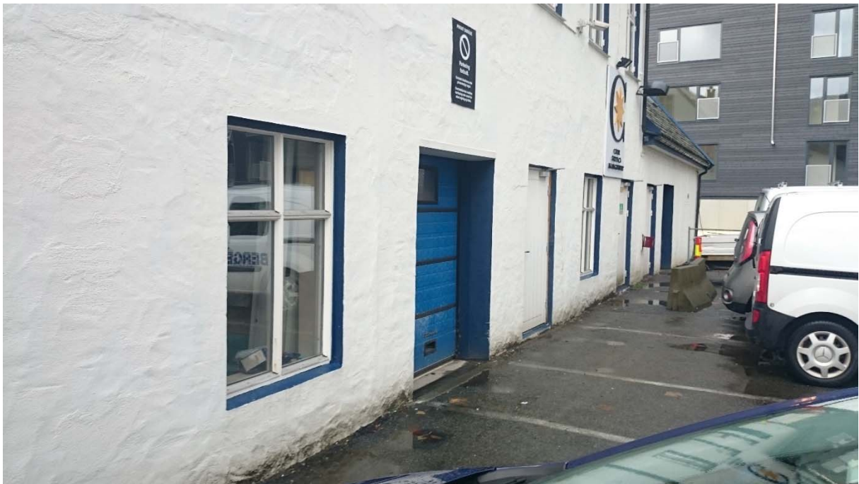
Sprossevindu i første etasje.
