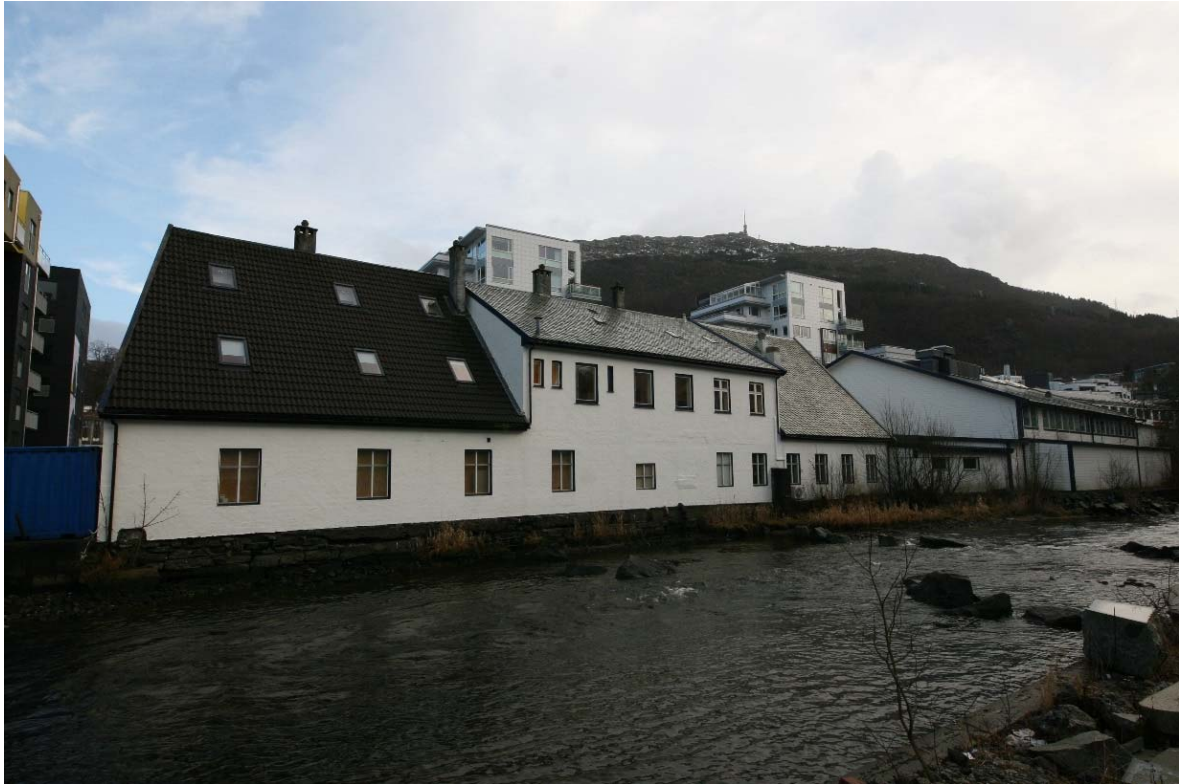
«Cementstøperiet» i dag, sett mot øst. Møllendalselven i forgrunnen. I andre etasje er det satt inn flere vinduer uten sprosser eller krysspост.
