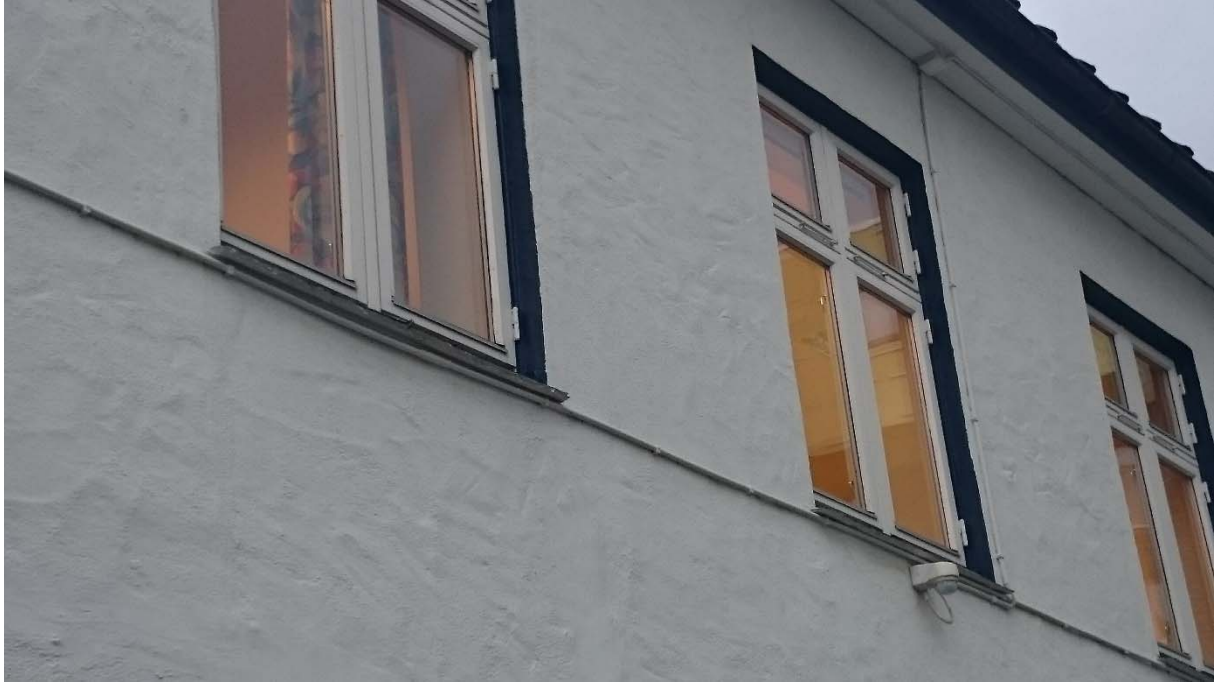
Krysspostvinduer i andre etasje, med salbenkbeslag i skifer.
