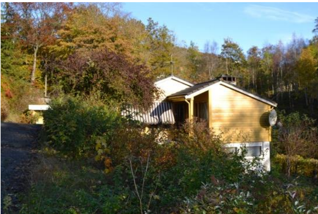
9. Sandbrekkevegen 17, gnr. 12, bnr. 224 Arkitekt: Bjørn Simonnæs Enebolig, oppført 1966, BRA 189m 2 .
