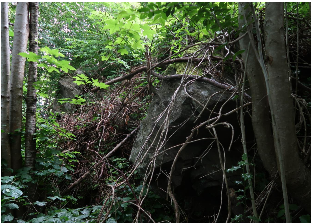
Bilde 1. To avløste bergblokker/-partier øst i planområdet.
