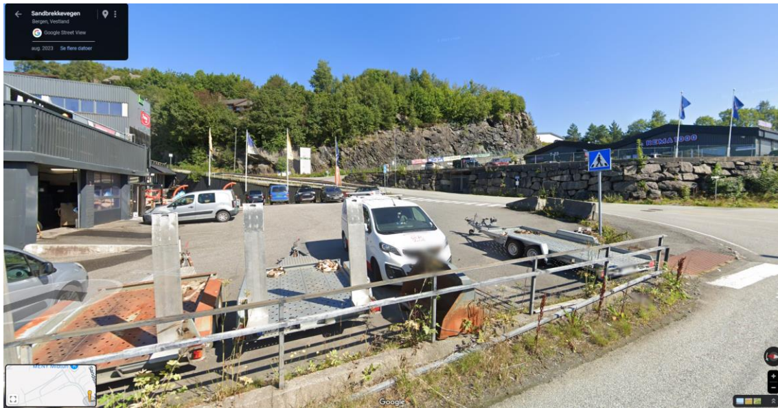
Figur 6: Foto fra Google Street view. Perspektiv mot øst, litt utenfor østlige del av planområdet (Kavli). Foto viser en større skjæring mot vei, sammen med tynne overdekkende masser.
