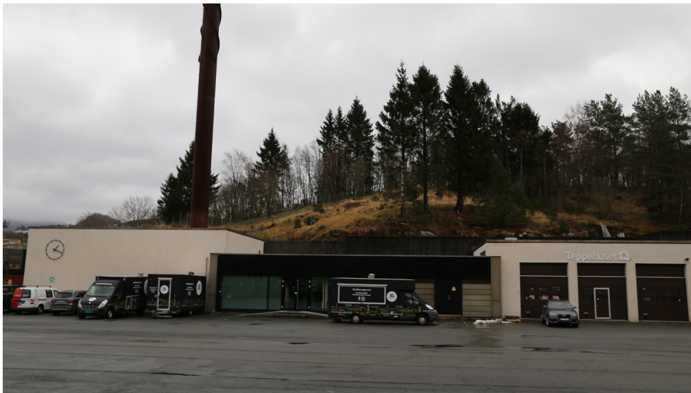
Bilde 16. Bak bygget i bildet skal et nytt bygg integreres i terrenget
