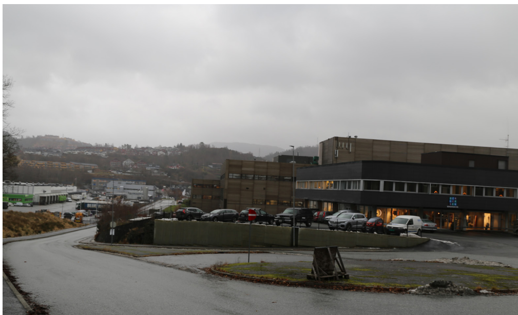
Bilde 15. Enden av den industrielle delen i Sandbrekkesletta med rundkjøring i enden - næringsbebyggelse nedover
