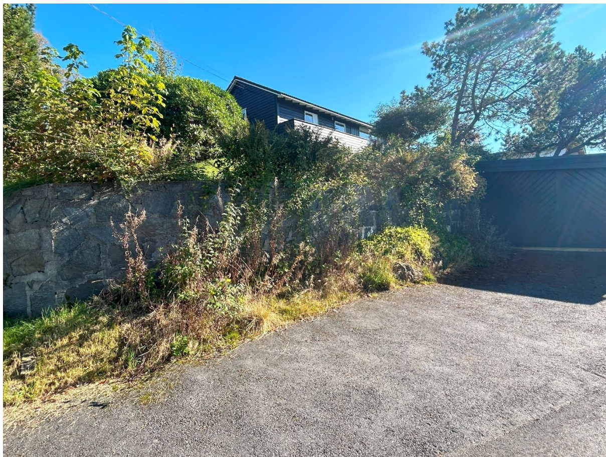
Støttemur mot sørhaugen 2 sett fra bakside av carport.
