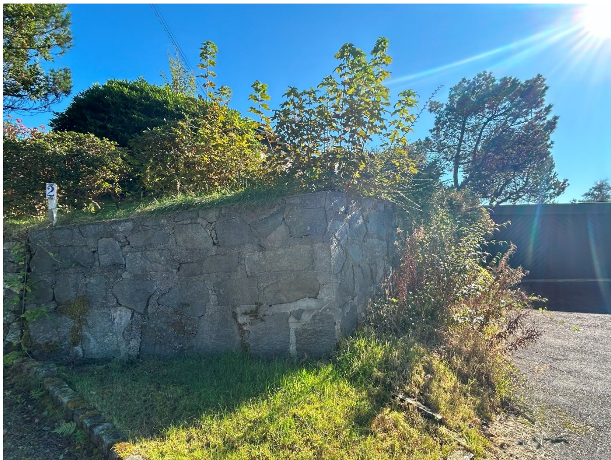
Støtemur fortsetter (baksida av carport).
