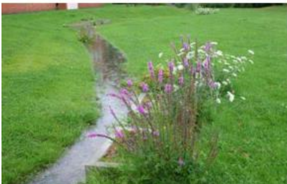
Figur 84- Prinsipp/illustrasjon gresskledd vannvei/infiltrasjonsgrøft. Kilde VA-rammeplan Haugen VAA
