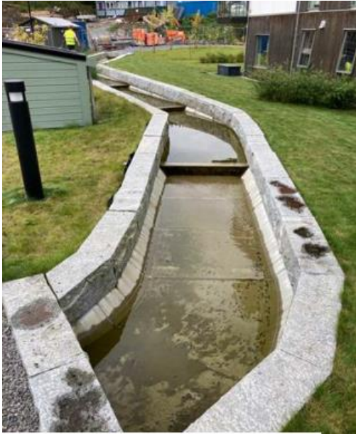
Figur 85- Prinsipp/illustrasjon åpen kanal/vannvei. Kilde VA- rammeplan Haugen VVA
