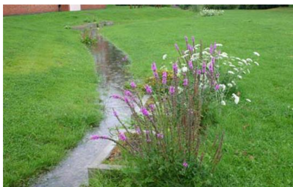
Figur 5 - Grasskledd vannvei/infiltrasjonsgrøft
