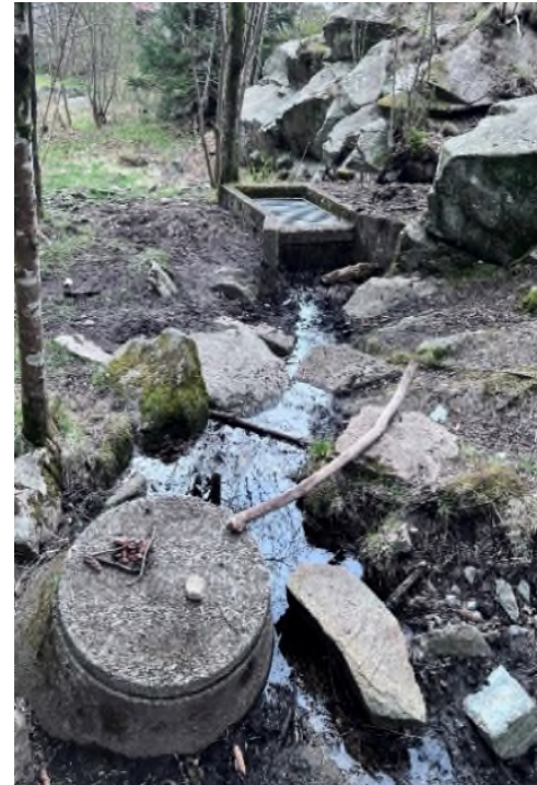
Figur 24. Bekkeinntak og området oppstrøms bekkeinntak.
