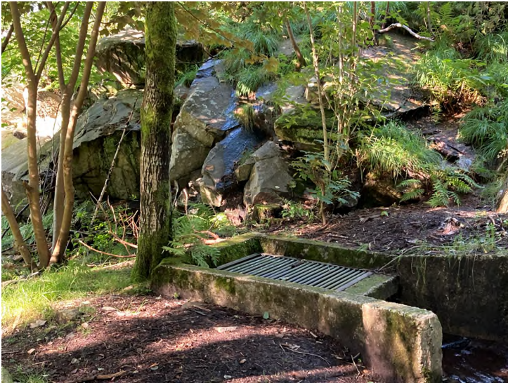
Foto av eksisterende bekkeinntak, der bekken avsluttes i en dam
