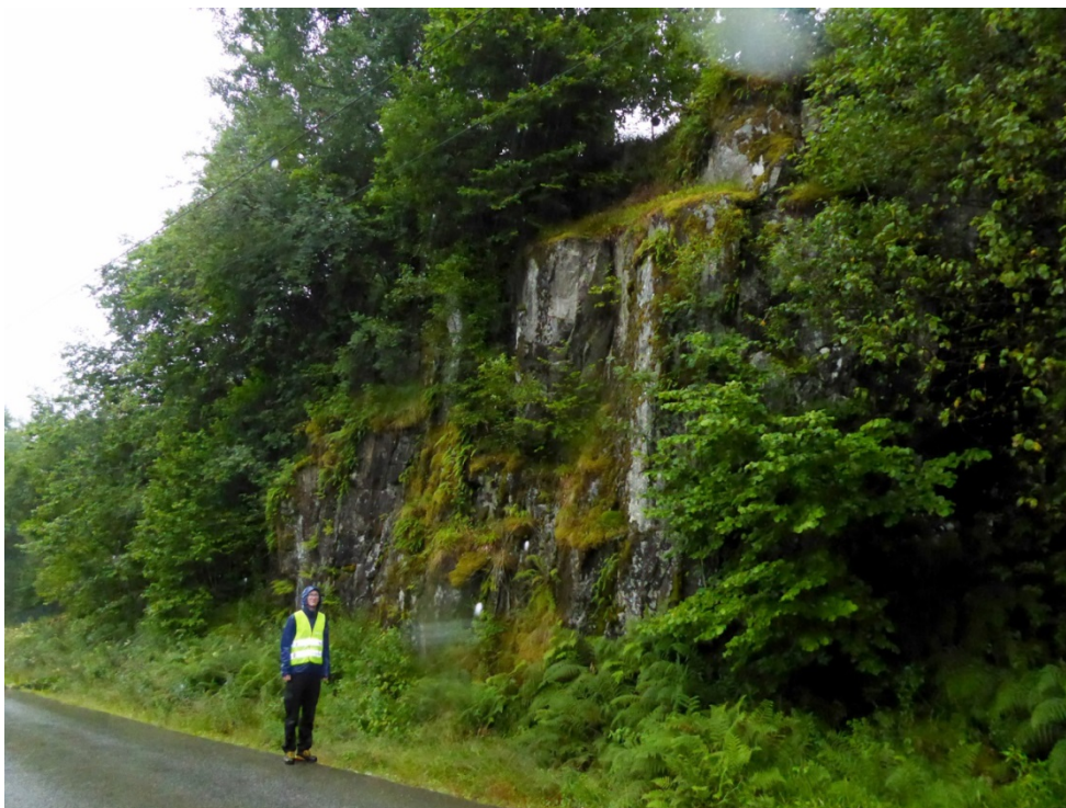
Figur 8: Skjæring i øst (figur 7).
