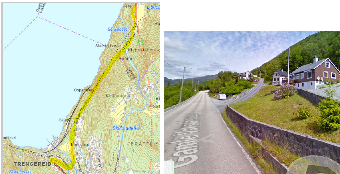
Figur 11 Venstre: Gamle Vaksdalsvegen (gul markering) får økt trafikk i anleggsfasen. Høyre: Boliger langs Gamle Vaksdalsvegen (Foto: Google Street View).
