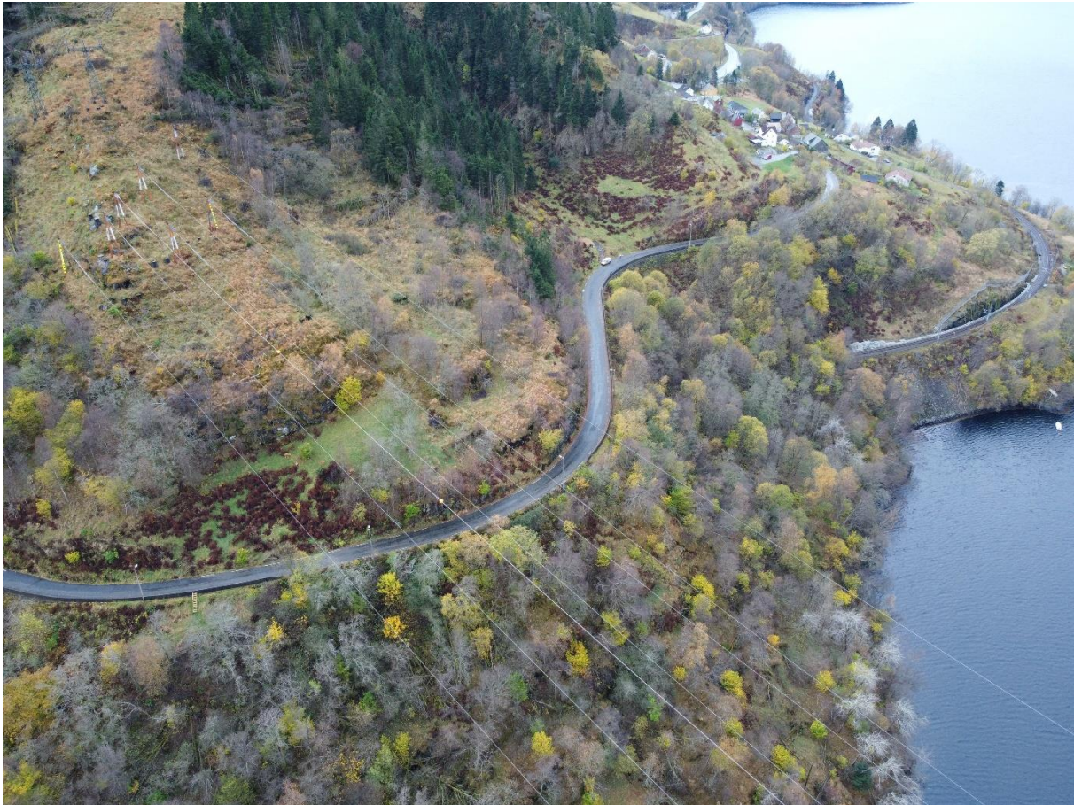
Figur 5-4 Dagens situasjon ved Skjerberget/Naustvika. Kraftledninger som går over fjorden, Romslovegen som går i dagen og eksisterende jernbane som går inn i tunnel. Bebyggelse på Romslo. Barskog i øvre del av området, mens skogen ned mot fjorden er dominert av løvskog. (Foto: FAS)
