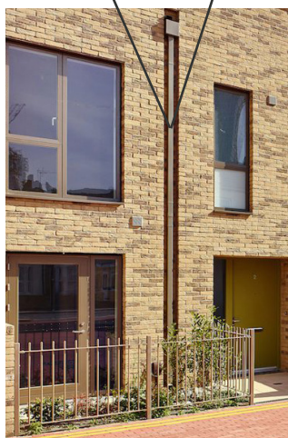
Eksempel på nedløp innlemmet i fasaden
