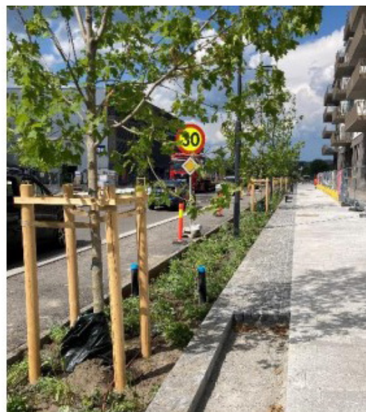
Figur 4-76 Eksempel på blågrønn kanal i byområde (ny hovedgate i Lørenskog sentrum under bygging). Den 1,5 m brede grøntkanalen håndterer overvann og flom fra sidearealene med tverrfall mot kanalen. Kanalen har også et sammenhengende lengdefall. I Grønneviken kreves tett bunn for å unngå infiltrasjon til forurenset grunn. Bilde: Pilot Grønneviken- prinsipp for overvannshåndtering. Dronninga landskap i samarbeid med COWI.
