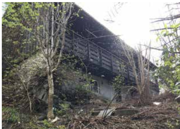
Dagens situasjon. Fasade mot sørvest.
