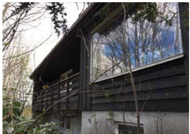
Dagens situasjon. Fasade mot sørvest.
