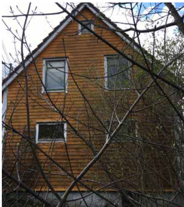
Dagens situasjon, fasadar mot nord.
