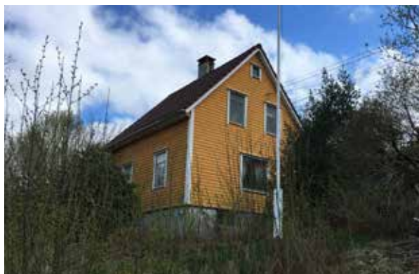
Dagens situasjon, fasadar mot vest og sør. Her ser ein at alle originale vindauger er skifta ut.
