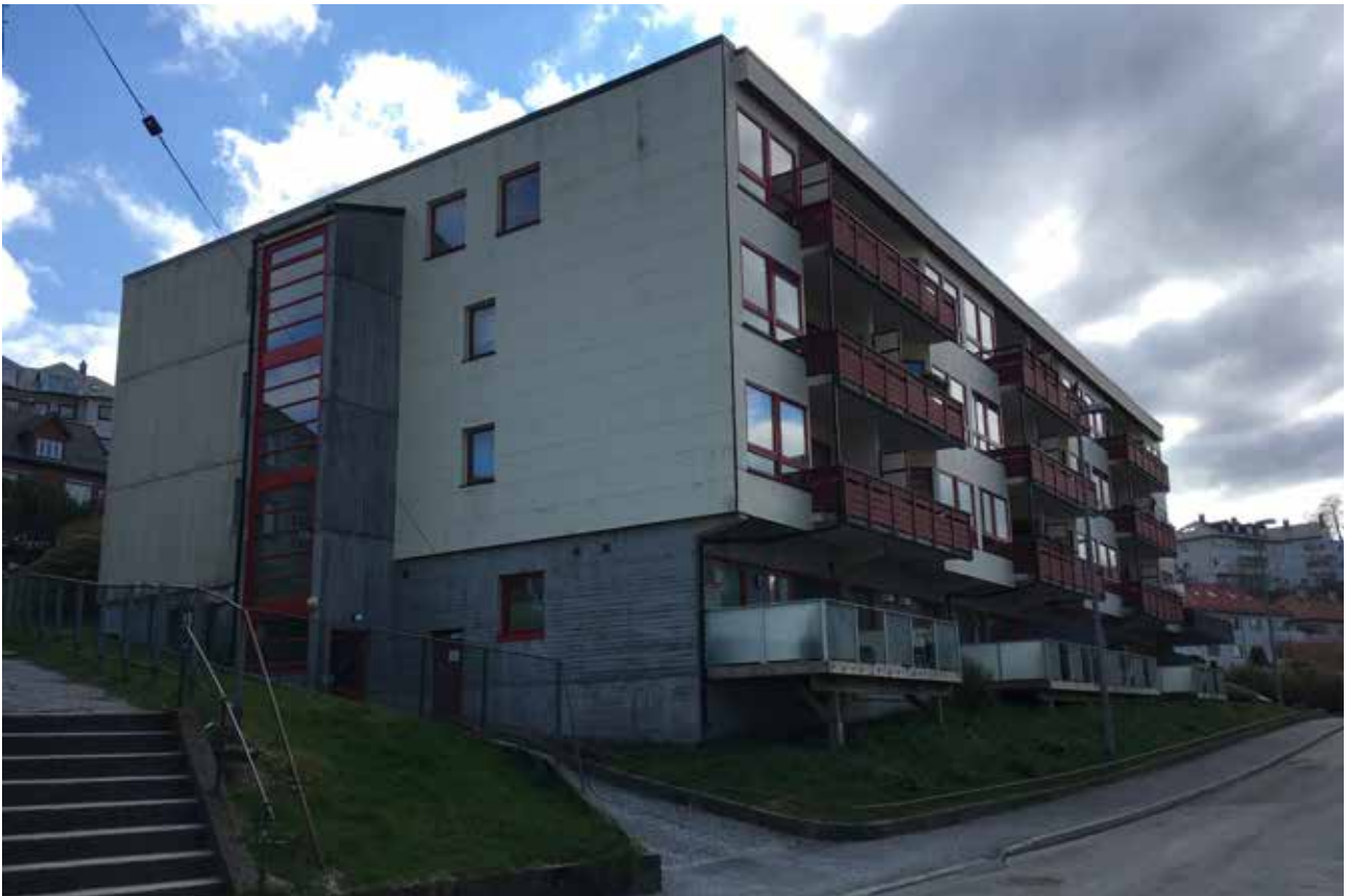
Dagens situasjon, fasade mot nord og vest. På nordvendt fasade er det sett i nokre nye vindauger. Ein ser også fasadeendringane i underetasjen på vestvendt frå 2018.
