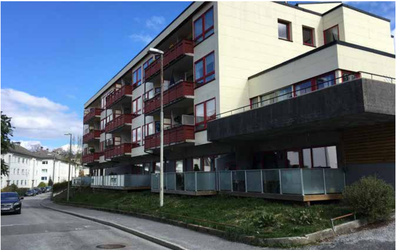
Dagens situasjon, fasade mot vest og sør. Her ser ein fasadeendringa i underetasjen frå 2018.
