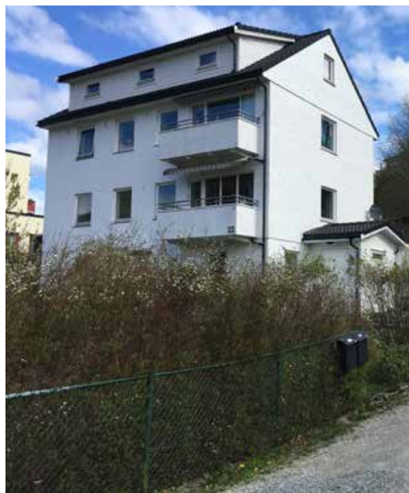
Dagens situasjon, fasadar mot vest og sør. Her ser ein det nye, store takutsticket på den vestvendte fasaden. Ein ser også det vesle tilbygget mot sør. Begge desse representerer eit betydeleg brot med det opphavslege stiluttrykket.
