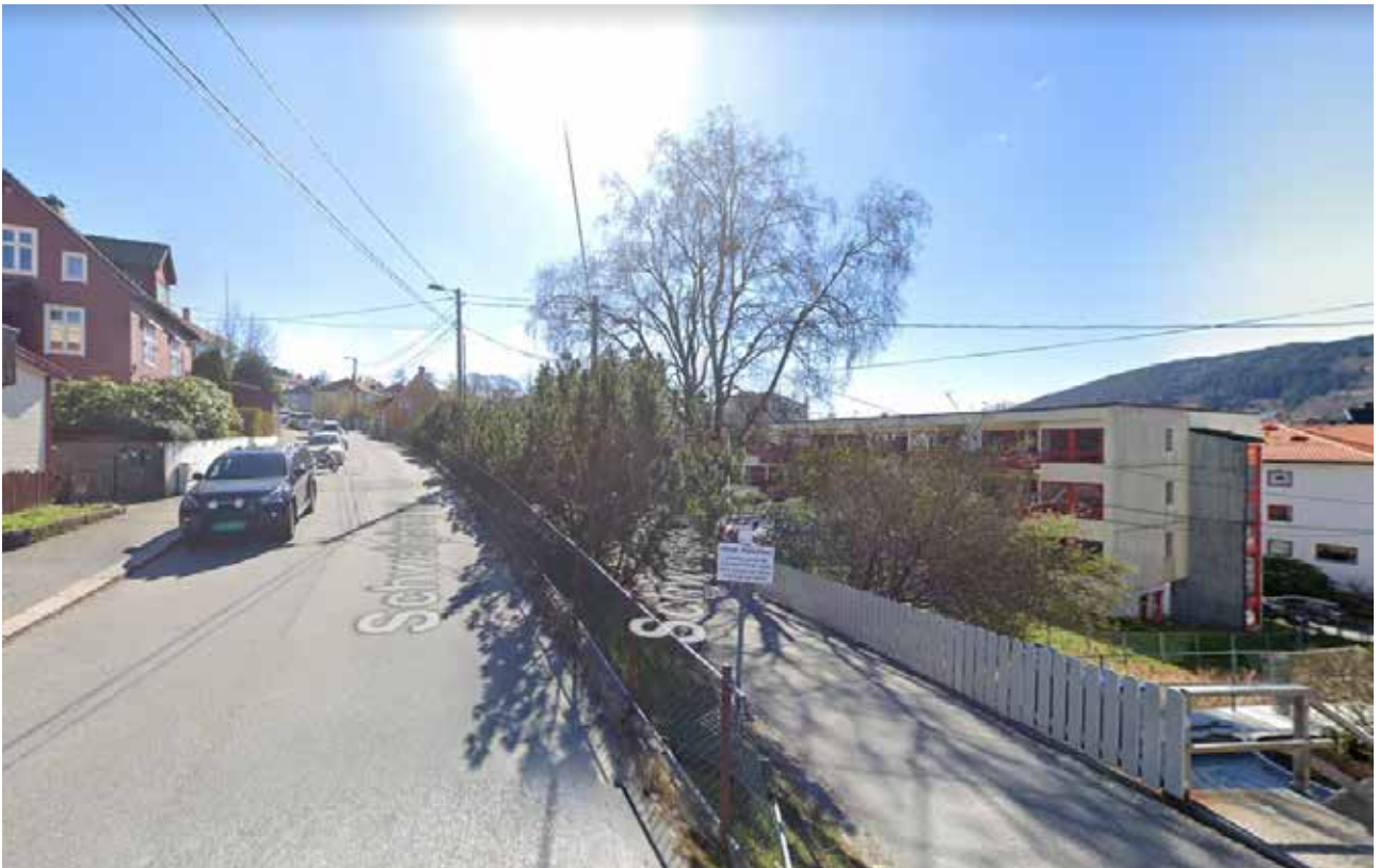
Oversiktsbilde planområdet, sett frå nord. Her ser ein langs Schweigårds vei. I midten av bildet kan ein skimte det gule huset frå 1918 med adresse Schweigårds vei 53. Til høgre i bildet ser ein bu- og servicesenteret frå 1976 med adresse Schweigårds vei 51. Foto: Google maps.
