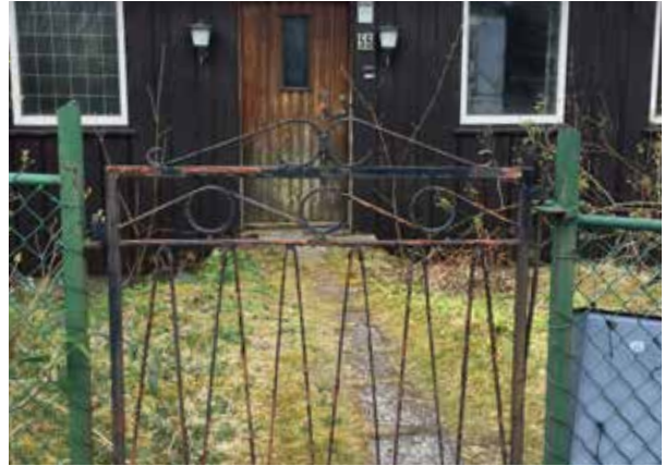
Dagens situasjon. Fasade mot nordaust. Detaljbilde.
