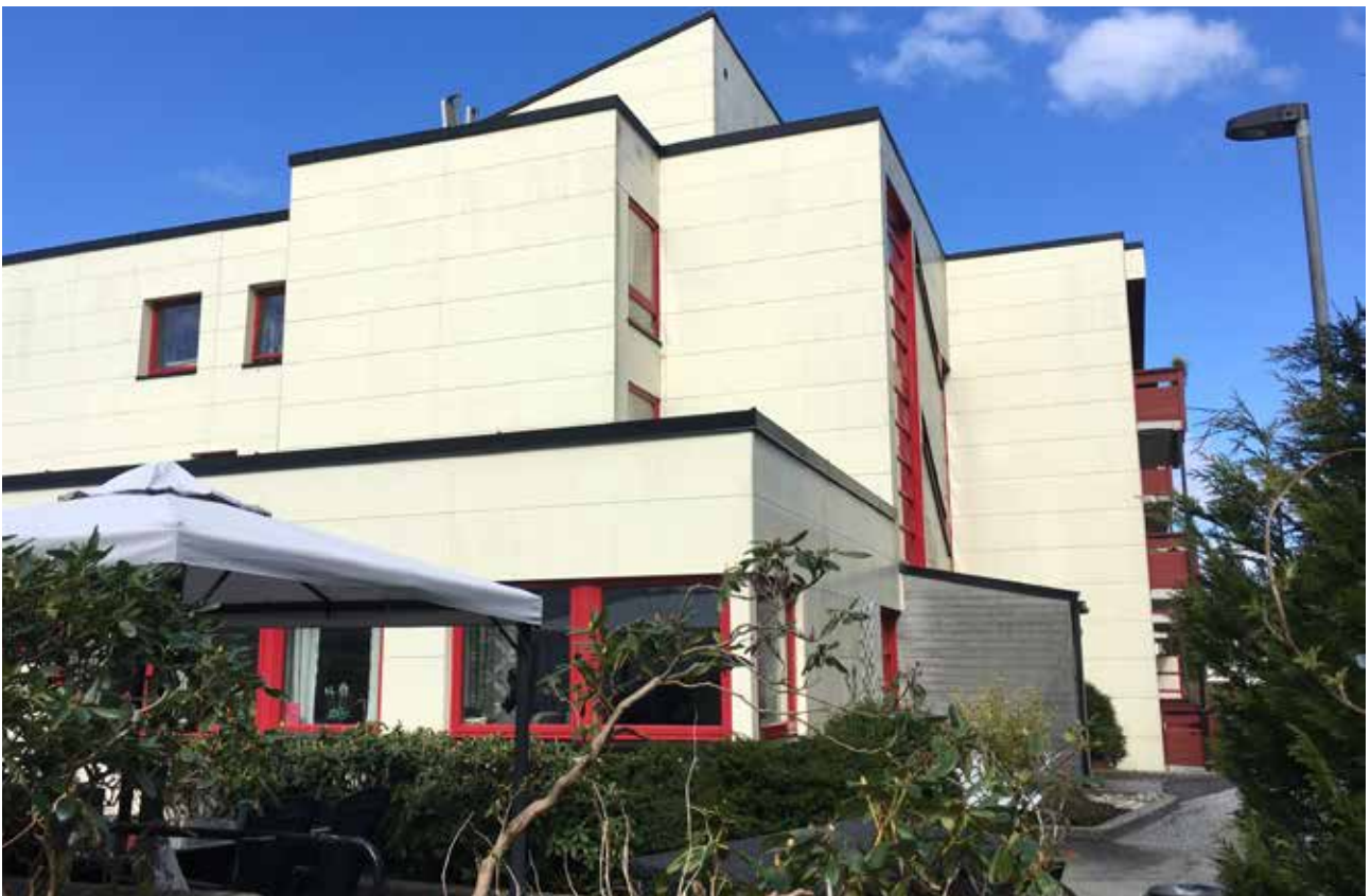
Dagens situasjon, fasade mot vest og sør. Her ser ein fasadeendringa i underetasjen frå 2018.
