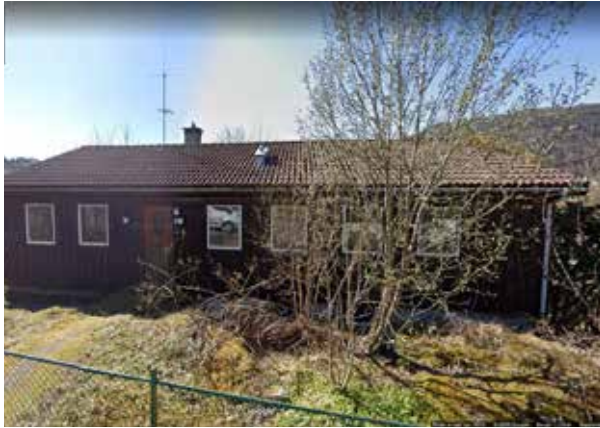
Dagens situasjon. Fasade mot nordaust.
