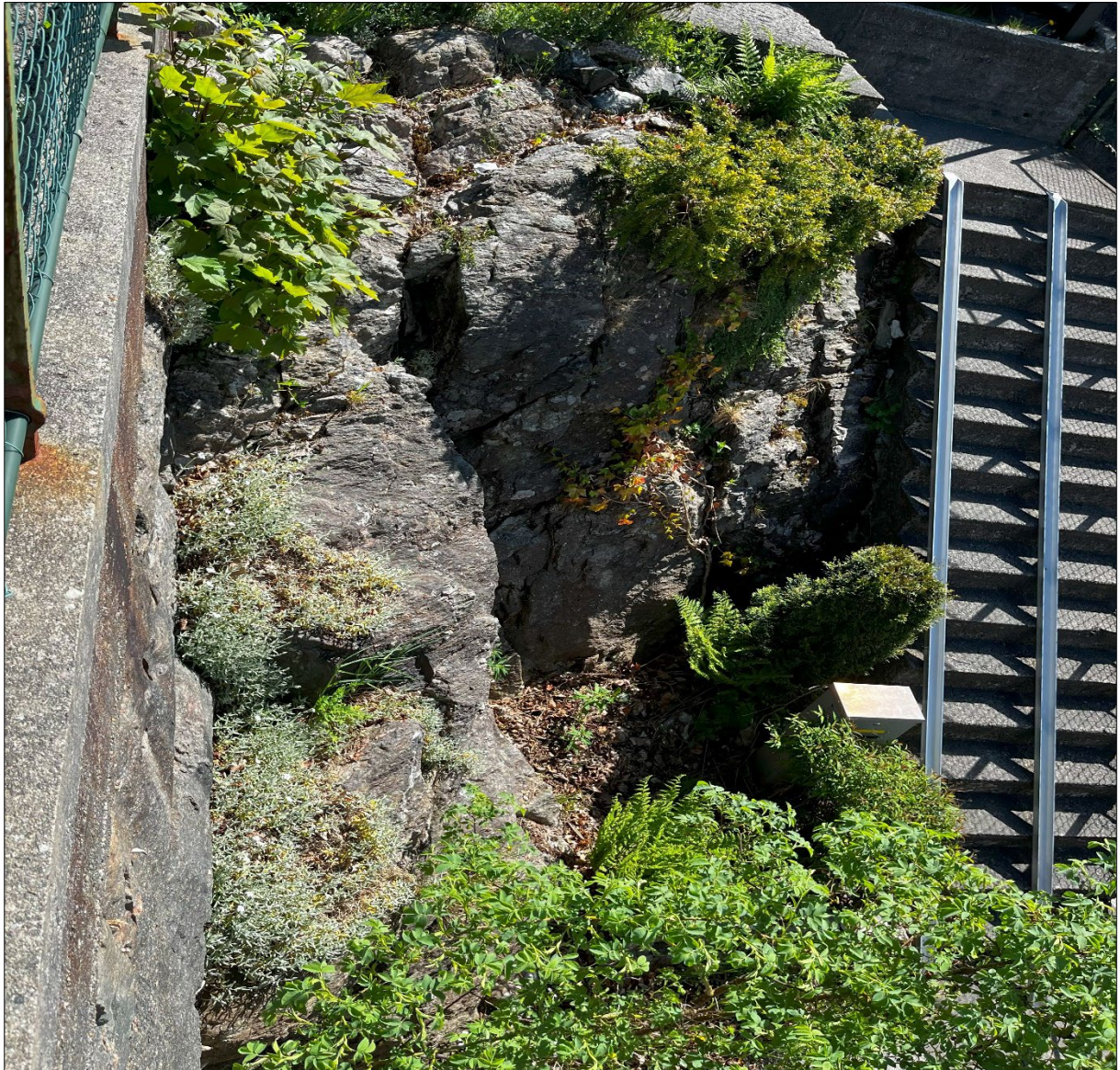
Figur 11: Fjell i dagen ved krysset mellom Gjøas vei og Astrups vei. Kilde: Sunnfjord Geo Center.
