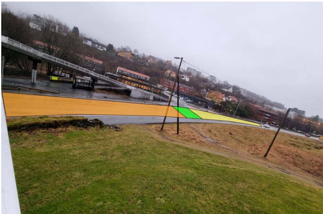
d) Markering av teljepunkt i sør
