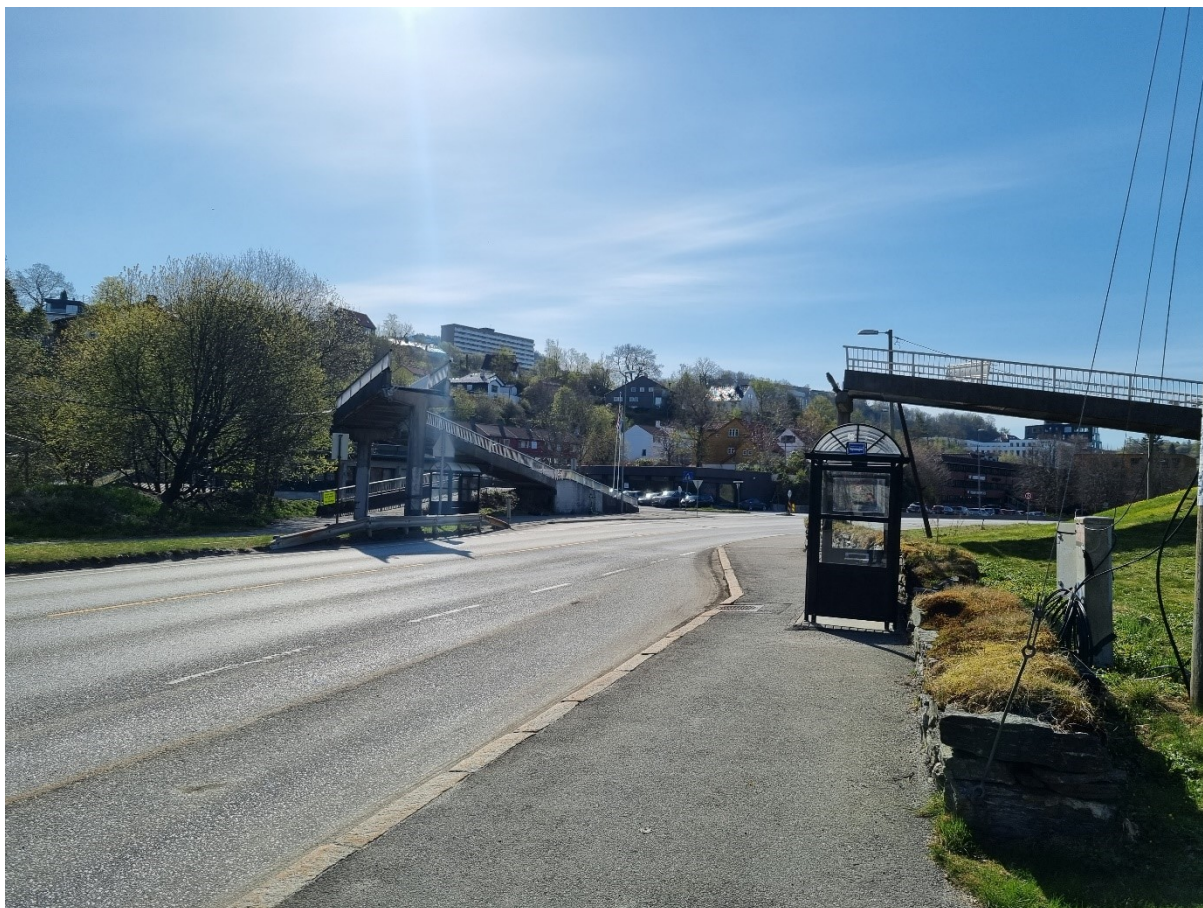
Figur 1.2: Bilete av den øydelagde brua på Storetveit
