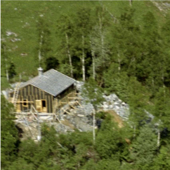
Figur 3-2: Flyfoto fra 1962. Viser bygning A under oppføring. Foto: Wideroe.
