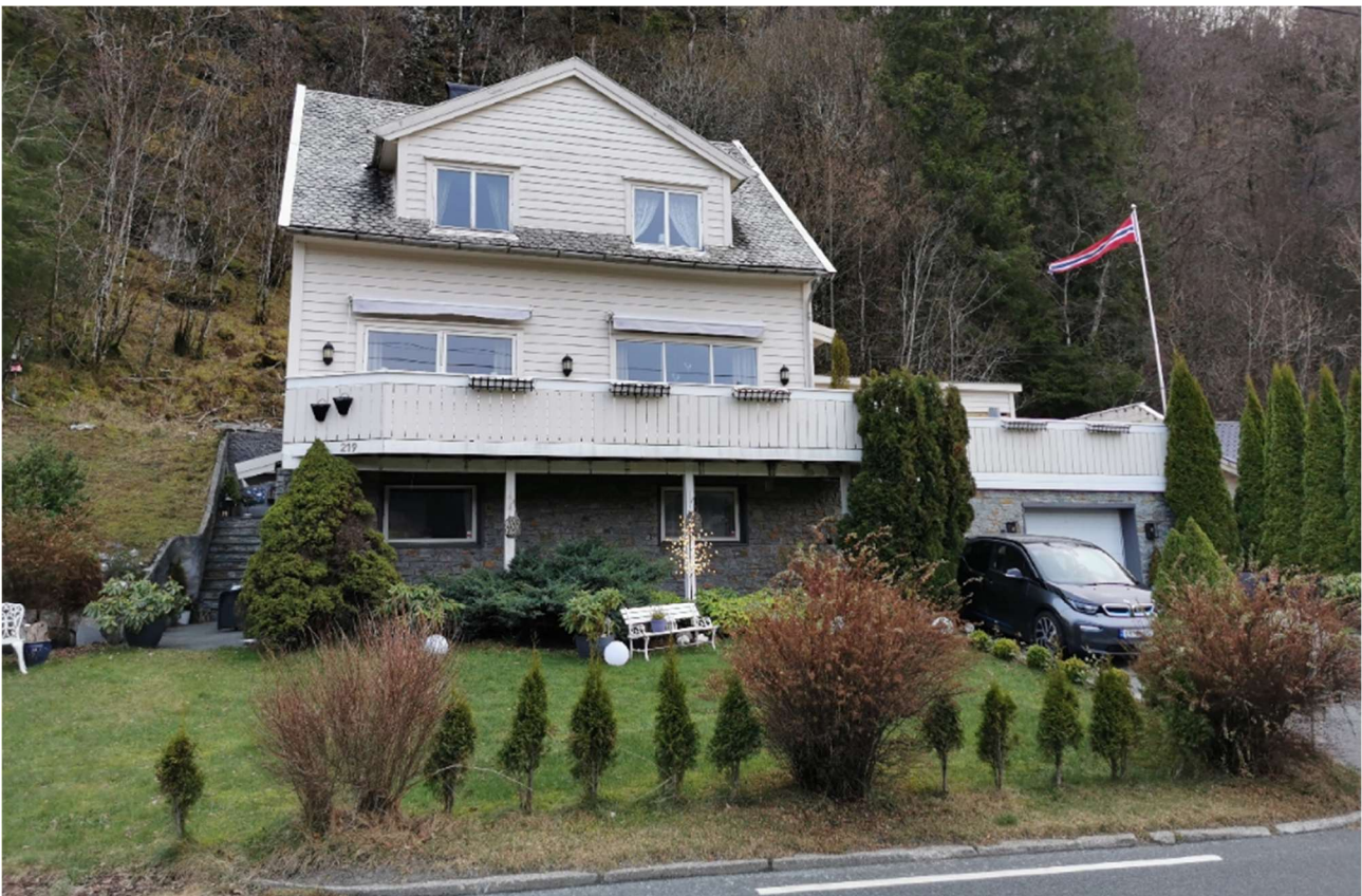
Figur 3-16: Huset sett fra Gaupåsvegen.
