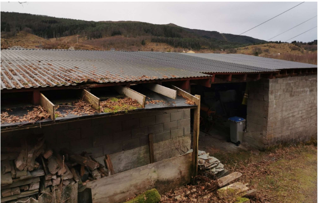
Figur 3-12: Bygg (bygg C) satt opp like inntil tidligere driftsbygning.
