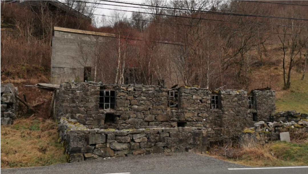
Figur 3-11: Ruiner etter driftsbygning. I bakkant sees oppsatt skur (bygg C) som har benyttet deler av tidligere grunnmur som fundament, dette er bygget på med forskalingsblokker.
