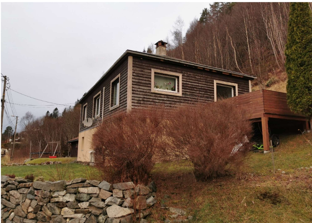
Figur 3-6: Huset (bygning B) slik det står idag. Inntrukne vinduer, kledning og nypusset mur i underetasje taler for at huset er blitt etterisolert i nyere tid.
