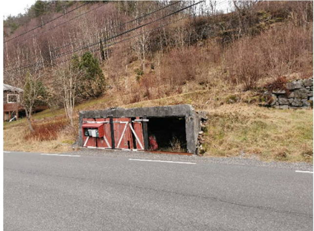
Figur 3-14: Dagens situasjon (bygning D).
