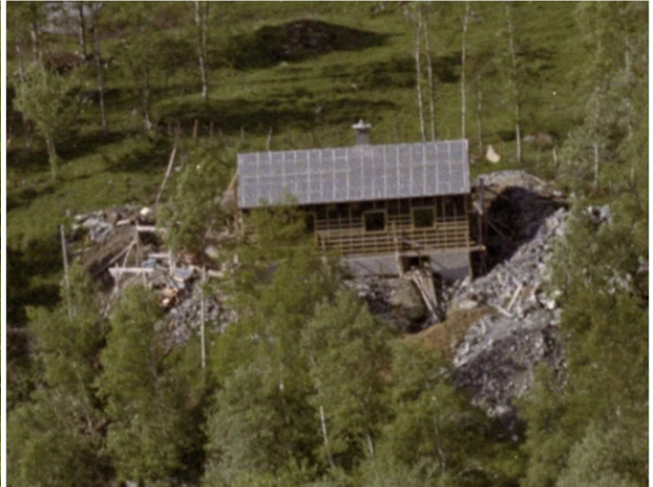
Figur 3-3: Flyfoto fra 1962, Viser bygning A under oppføring. Foto: Wideroe.
