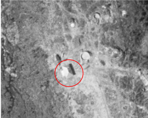
Figur 3-7 Flyfoto fra 1951 viser mannskapsbrakken på toppen av Kistehaugen ved lyskasterbatteriet. Foto: 1881.no
