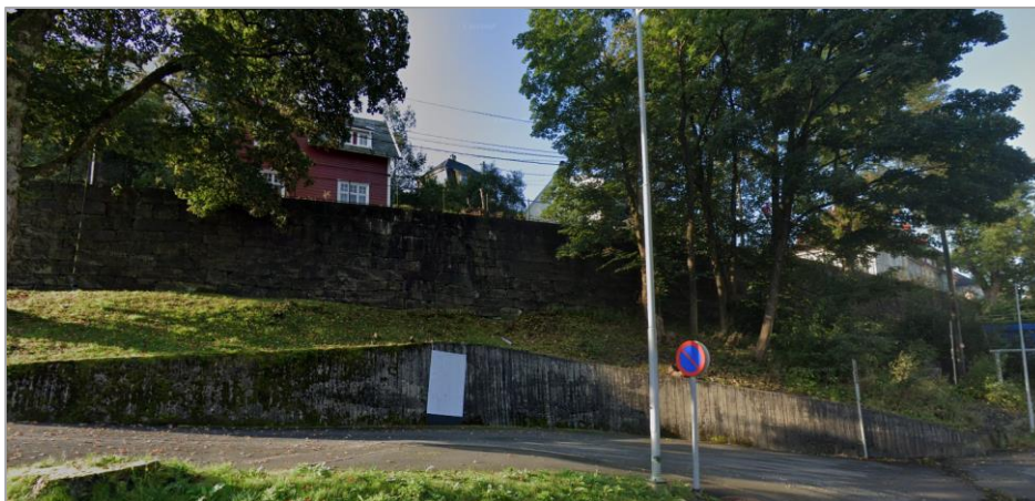
Figur 4-5: Stablesteinsmur vest i Klaus Hanssens øverst i bilde (kilde: Google Street View)
