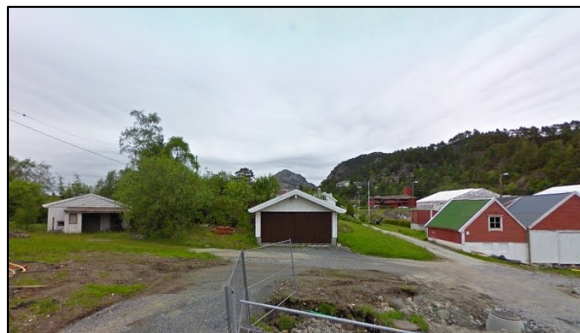
Figur 5 Garasje og arbeid med ny fotgjengarundergang. Skjermdump frå Google Maps.
