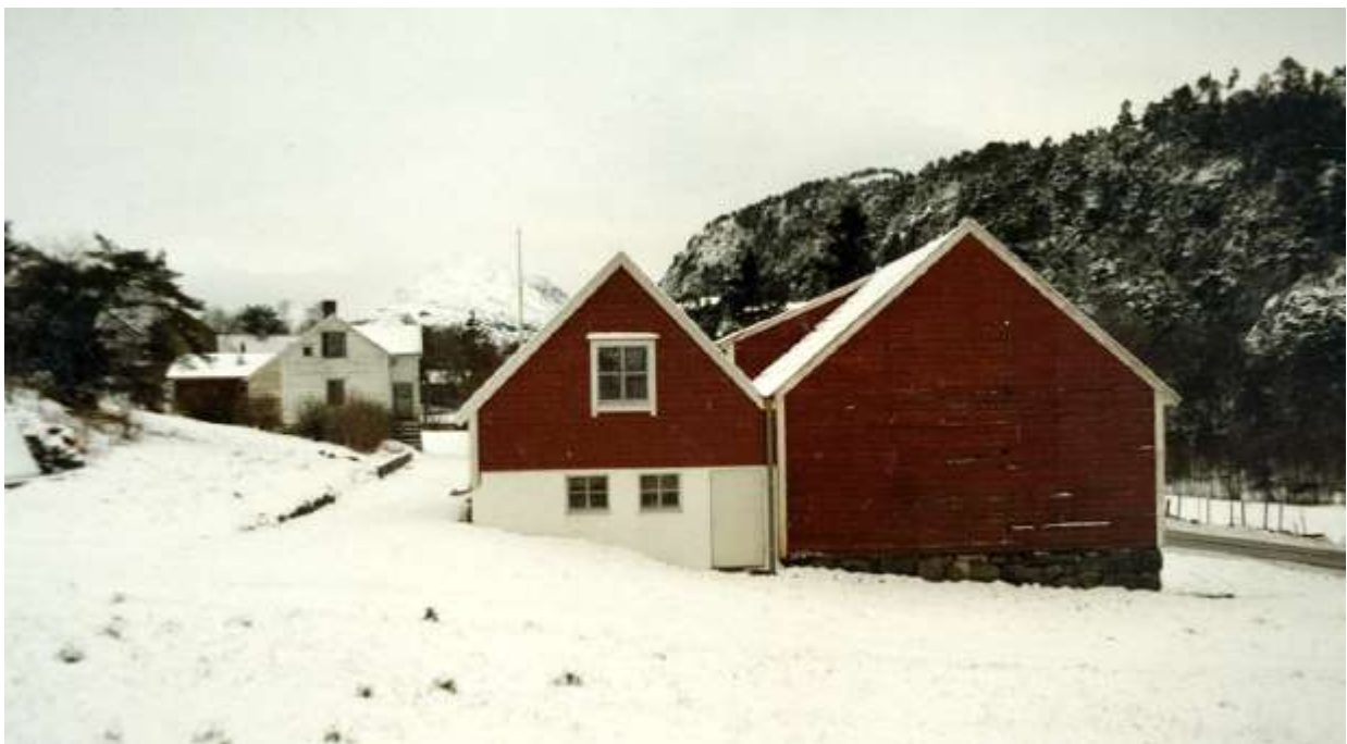
Figur 21: Sydfasaden på driftsbygningen. Foto vedlagt byggesøknaden i 1983.
