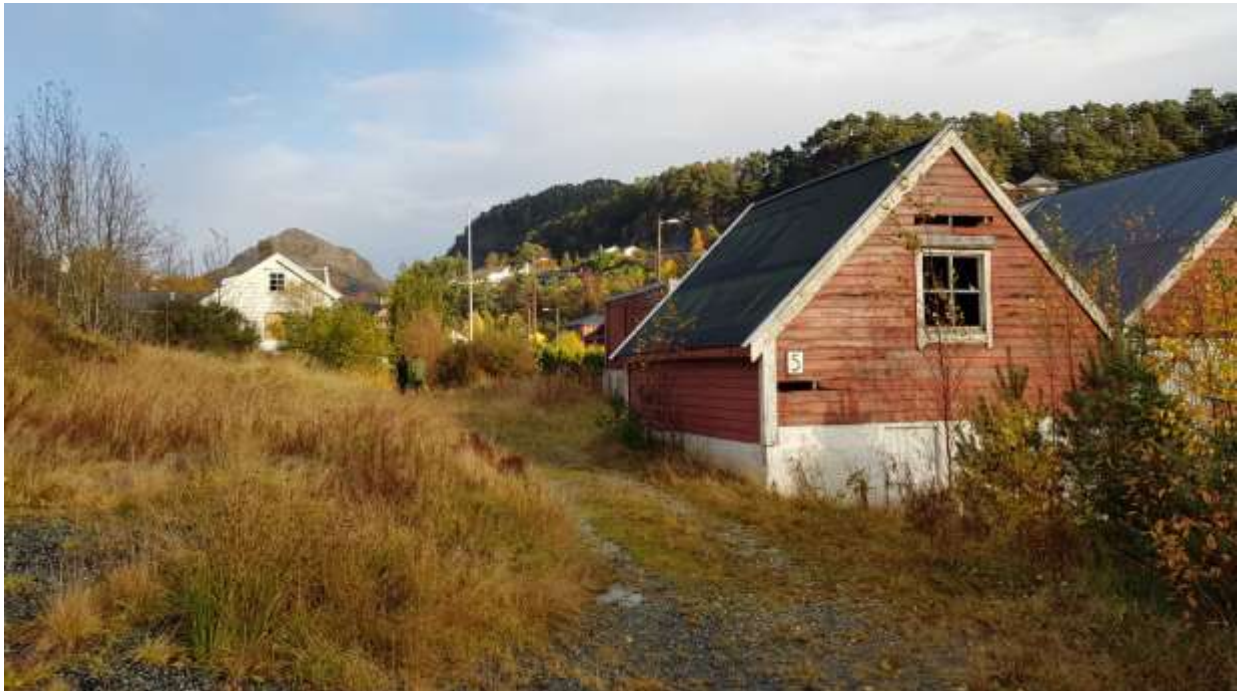
Figur 53: Vognhuset sett fra sør.
