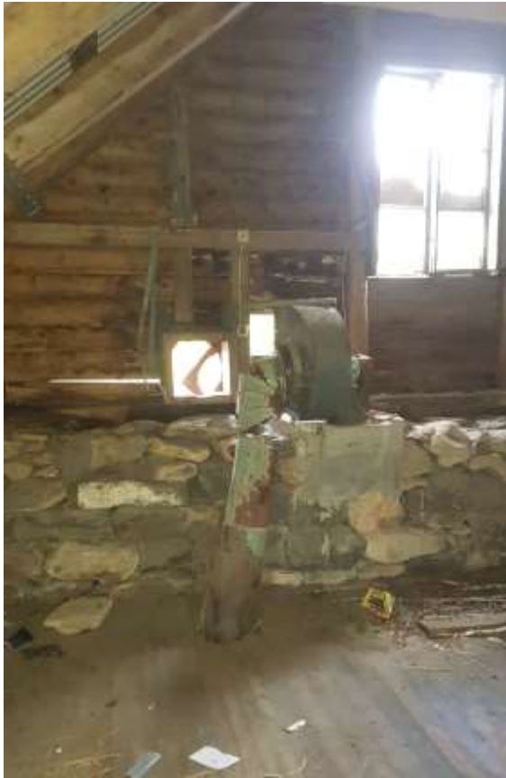
Figur 57: Detalj, vegg mot nord.
