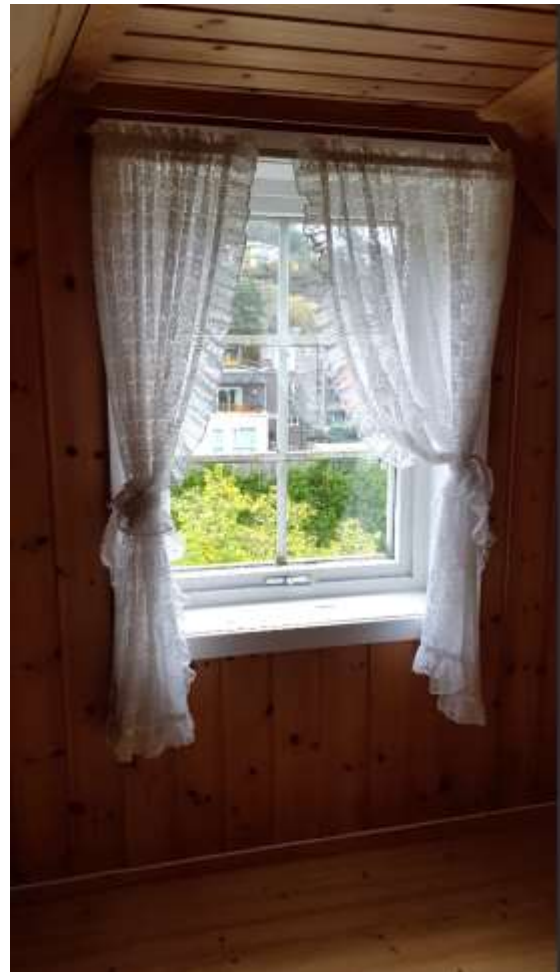
Figur 39: Vindu mot øst i annen etasje.
