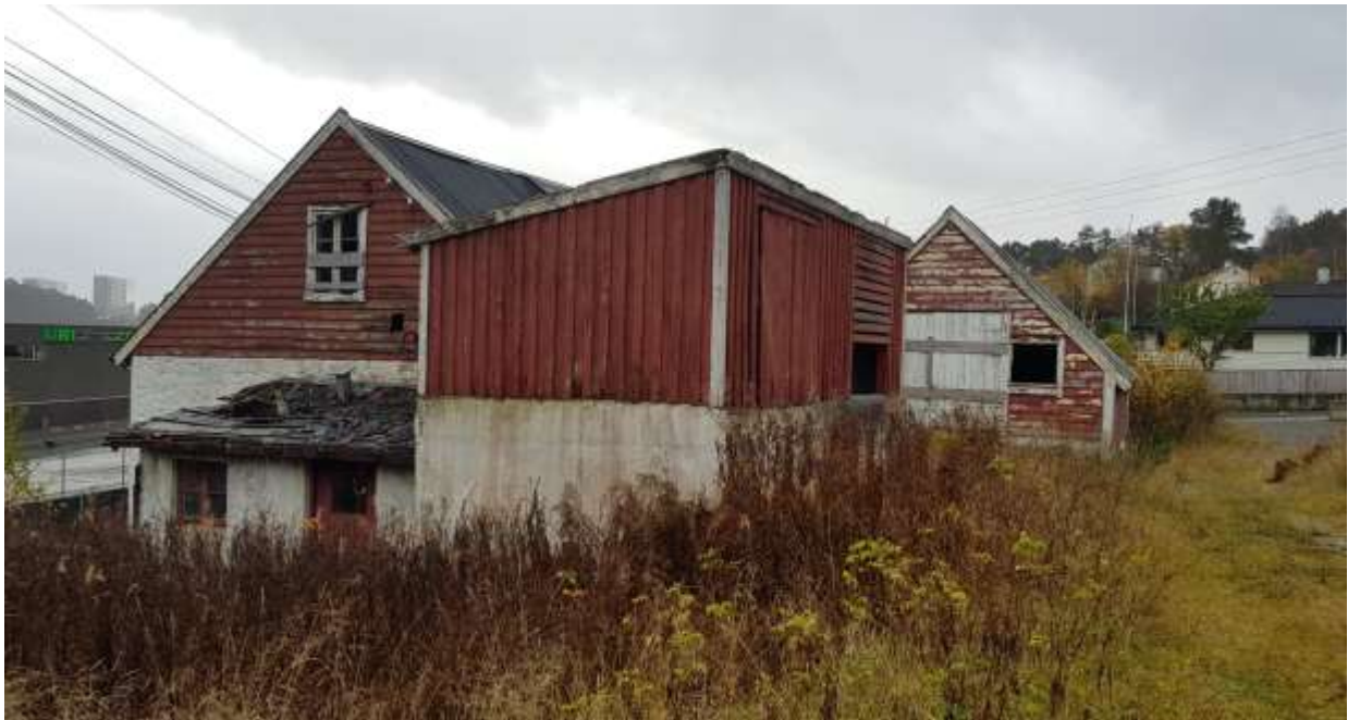
Figur 47: Driftsbygningens fasade mot nord.
