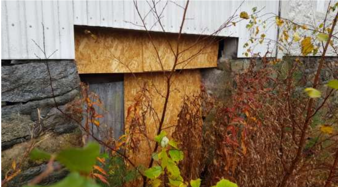
Figur 51: Stengt dør i grunnmur mot øst.
