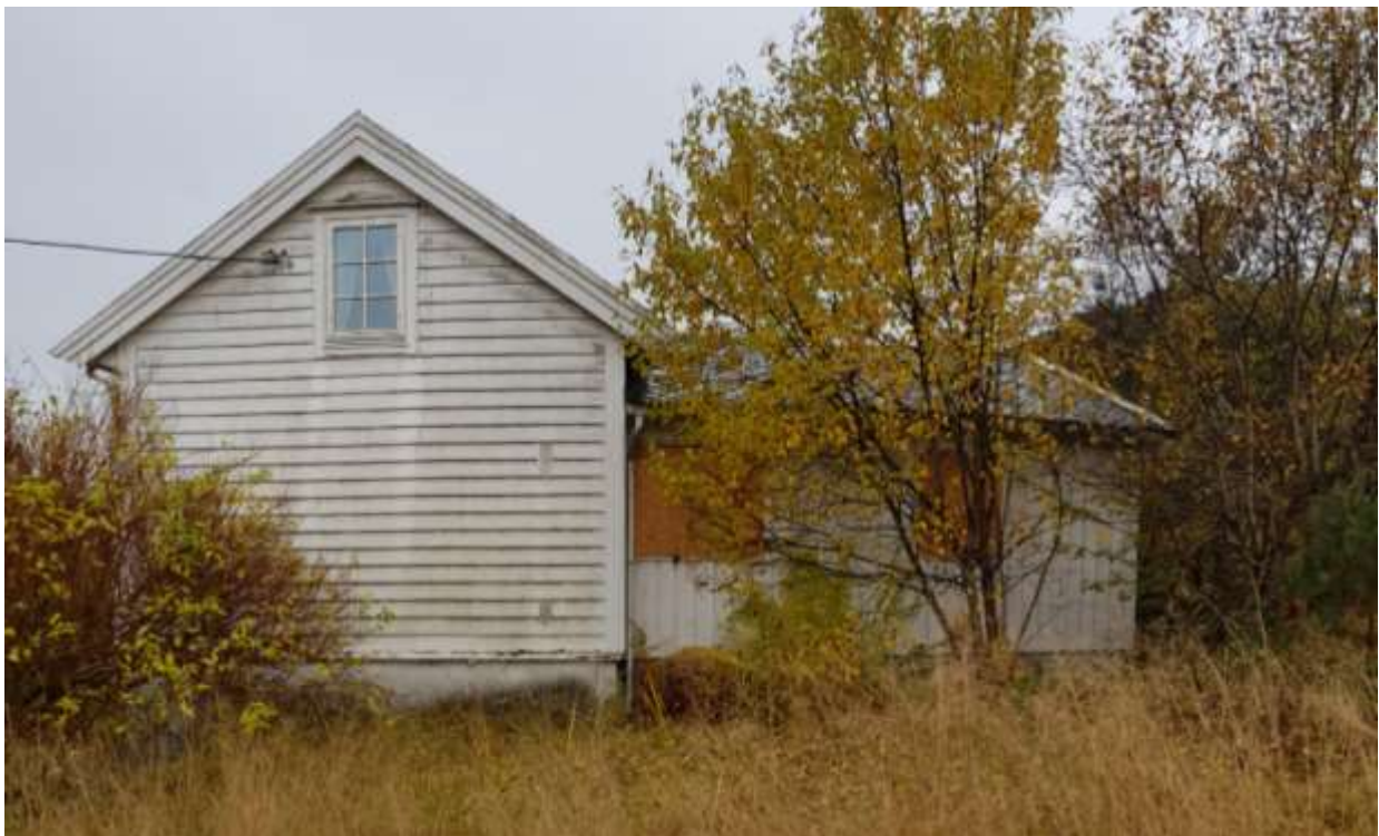
Figur 25: Fasade mot nord.
