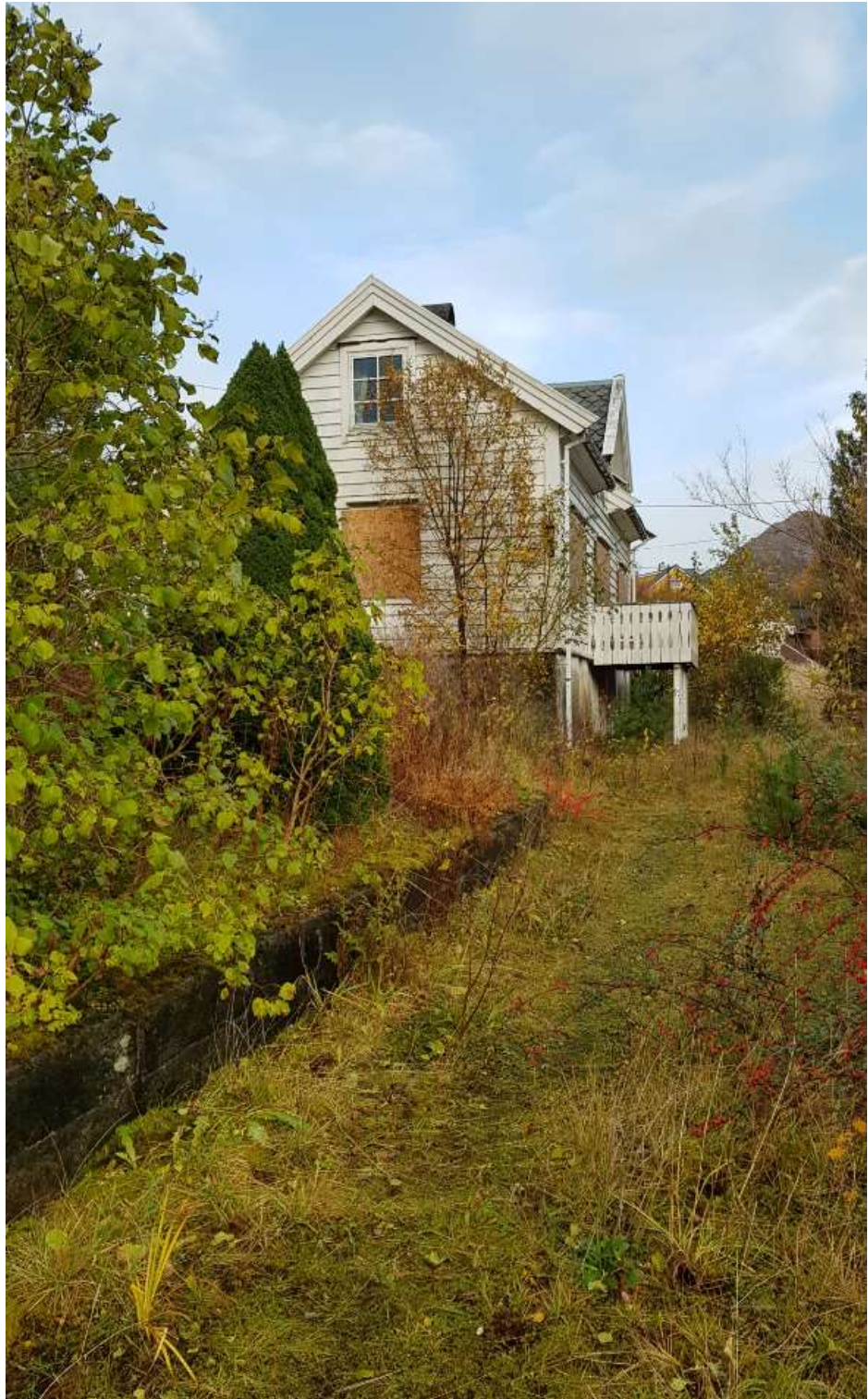
Figur 60: Den gamle veien gikk gjennom gårdstunet og er bevart. Tidligere lå inngangen til bygget på siden ut mot veien.
