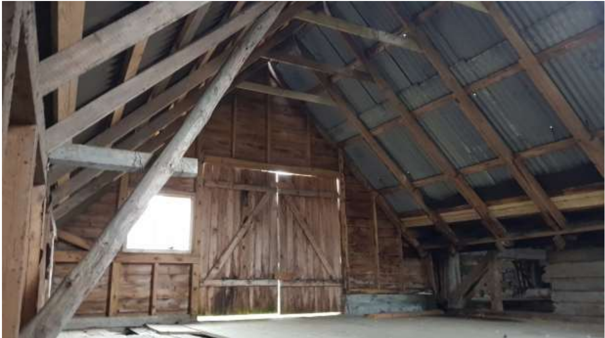
Figur 54: Vognhuset sett gjennom hull i veggen, bilderetning nord.
