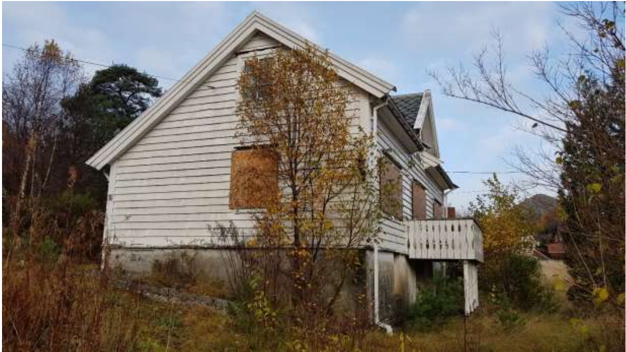
Figur 24: Fasade mot sør. Vinduet i andre etasje har blitt skiftet ut etter 1983, viser bilder og skisser.
