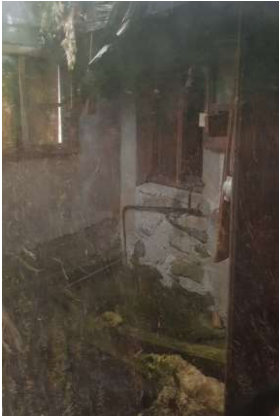
Figur 49: Bilde tatt gjennom vindu i utbygg mot nord.
