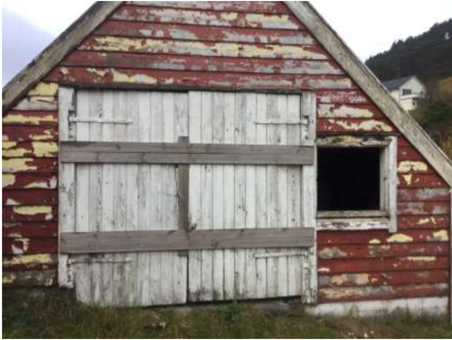
Figur 52: Vognhusets inngang mot nord.
