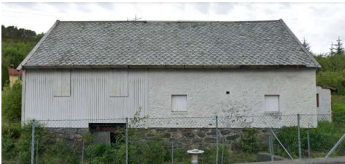
Figur 44: Driftsbygning (fjøsdel) mot øst. Den sørlige delen er kledd med metallplater, og nordlige er i pusset mur. Foto: Google Maps.
