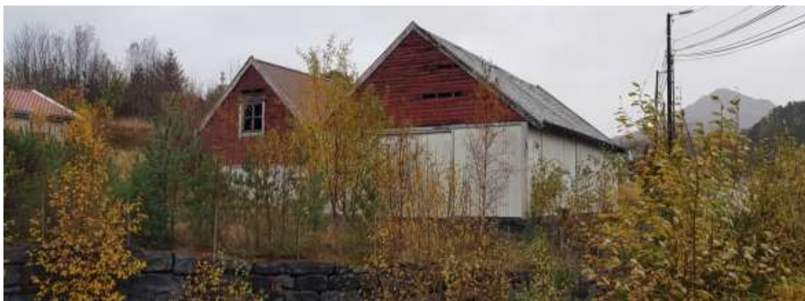
Figur 45: Fasade mot sør. Tidligere vogndhus til venstre. Fjøsdel til høyre.
