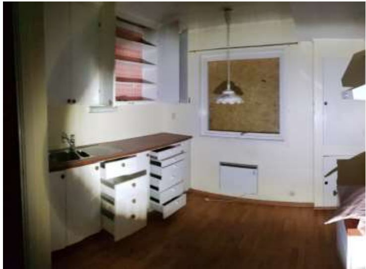
Figur 34: Kjøkkenet. Innredningen er typisk 1970-tall. Husmorvindu trolig satt inn ved ominnredningen etter 1975.
