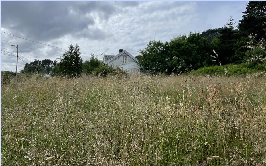
Figur 3. Bildet er tatt av våningshuset mot sør. Foto: Sweco.
