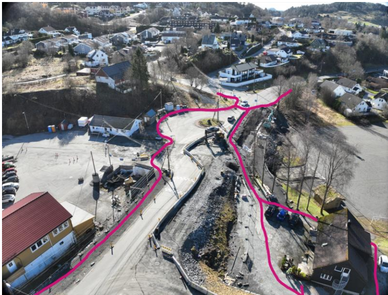
Figur 1 – Oversiktsbilde som viser ny gangvei opp mot Grimseidvegen
