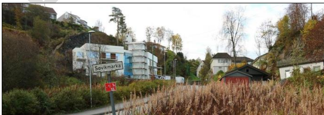
Figur 3-5: Leilighetskompleks i Søvikmarka 8 ved Steinsvikskaret sees sentralt i bildet, like utenfor plangrensen (Opus).
