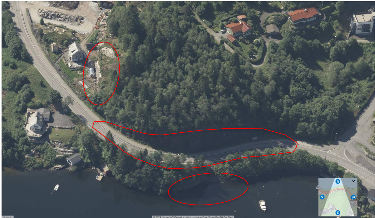
Figur 16: Utsnitt fra Skråfoto, 2024 (1881.no). Røde avgrensinger viser felt med bart fjell, både langs sjø og mot planområdet (begge sider av Steinsvikvegen), samt t.v. bilde hvor berg kommer tydelig frem som følge av at vegetasjon/trær er tatt ned.
