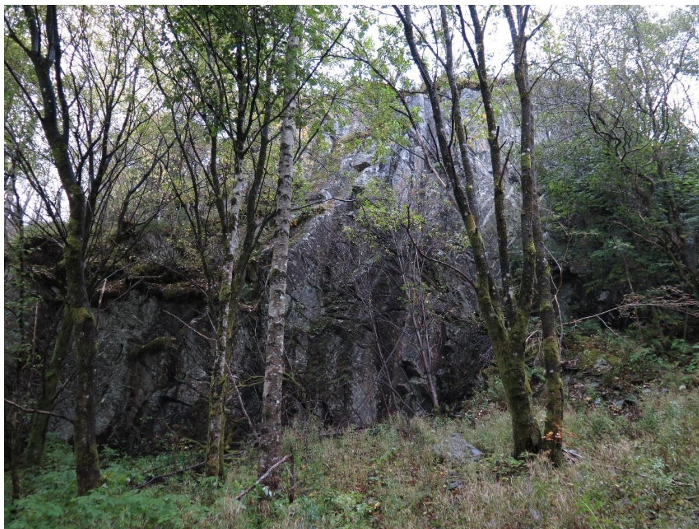
Bilde 1. Bergskrenten i skaret med påvist ustabilt berg.
