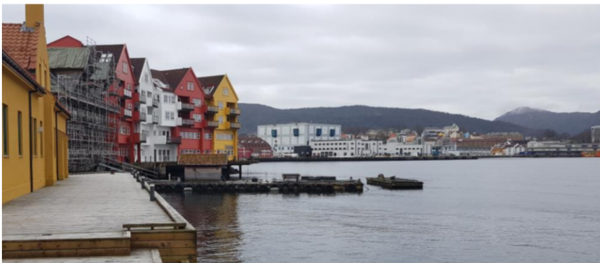
Figur 58. Sjøsiden foran Ludeboden Skuteviksbodene sett fra kaien ved Slaktehustomten.
