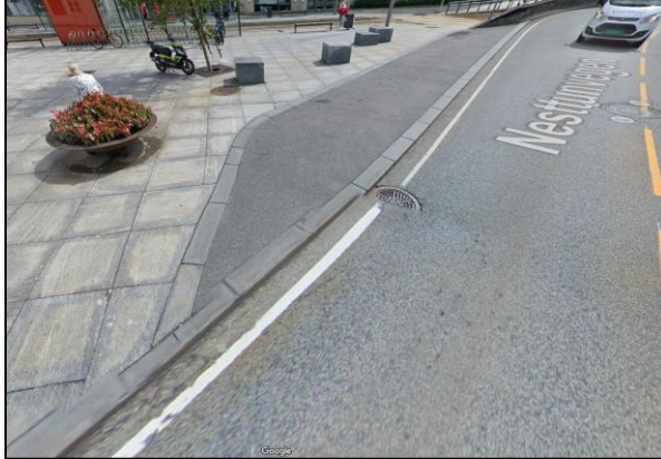
Eksempler på kombinert vareleveringslomme og fortau, med avvikende dekketype og liten eller ingen høydeforskjell, fra Nesttun sentrum (venstre) og Kaigaten (til høyre).
