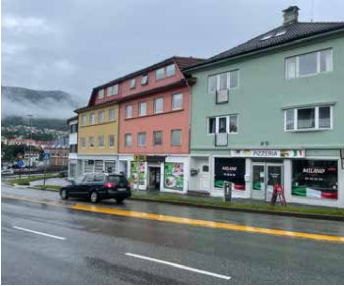
Fig 9 Eldre sentrumsbebyggelse med næring på bakkeplan og leiligheter over.
