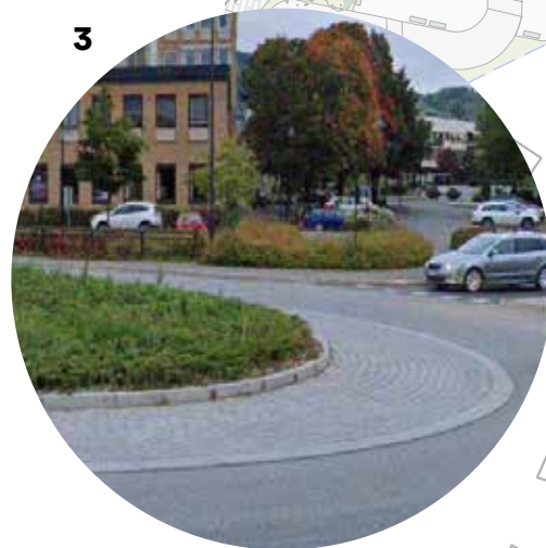
Fig 133 Overkjørbart dekke og vegetasjon i rundkjøring Plantefelt og platekantstein
