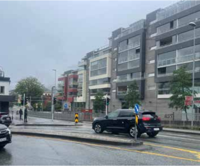
Fig 7 Wergeland Lokalsenter med nyere sentrumsbebyggelse og nedgang til bybane.
