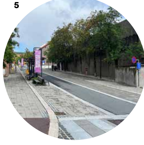
Fig 138 Wises gate, Lillehammer Opphøyd kryss med steinheller i ulike valør
