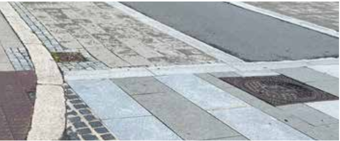
Fig 90 Referansefoto. Wises gate, Lillehammer Opphøyd, hellebelagt gangfelt.
