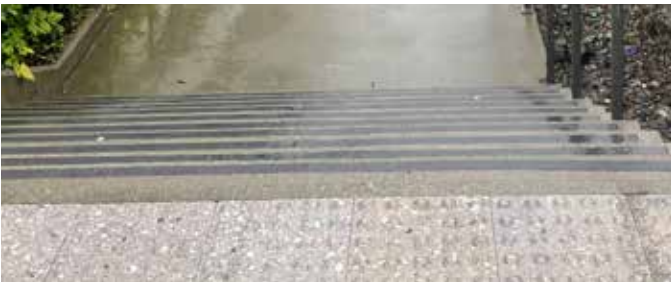
Fig 40 Eksisterende oppmerksomhetsfelt i granitt i topp av trapp nord for Wergeland terrasse
