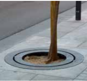
Fig 59 Gruberist i mørkt støpejern
