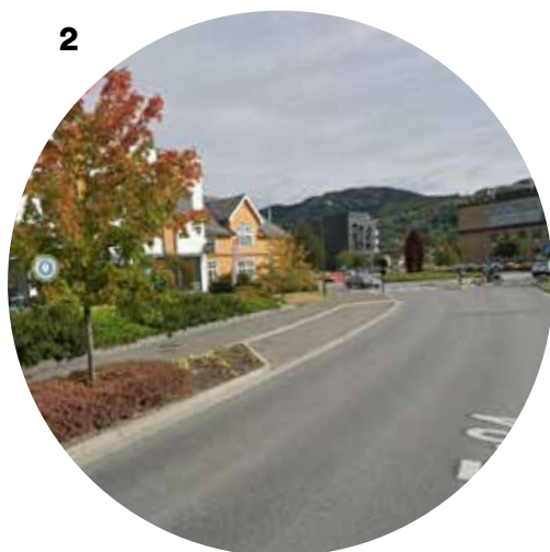
Fig 132 Ringsakervegen, Brumundal Plantefelt og platekantstein i kjørebane
