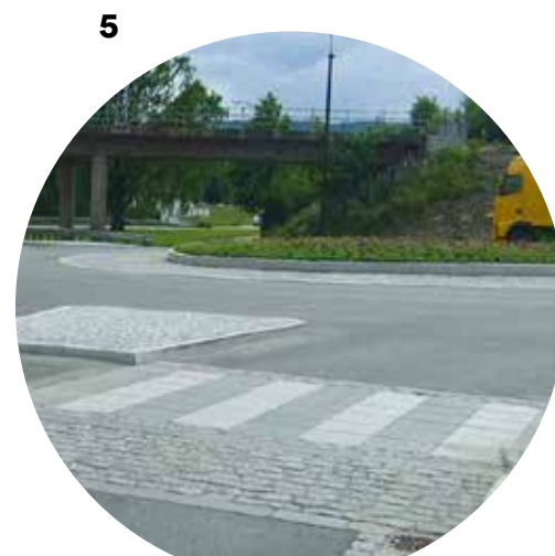
Fig 137 Ukjent Opphøyd gangfelt med smågatestein i oppramping og betongheller topp
