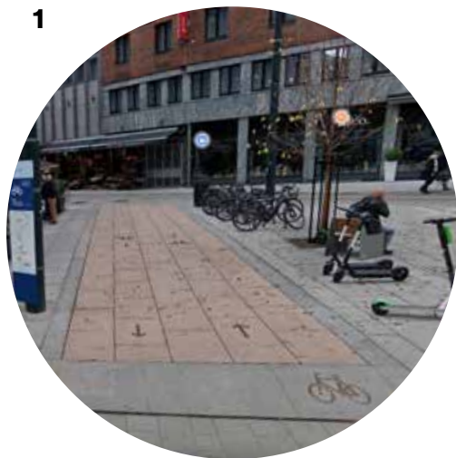
Fig 128 C. J. Hambros plass, Oslo Markert sykkelveg i fortausareal. Forskjellig valør
