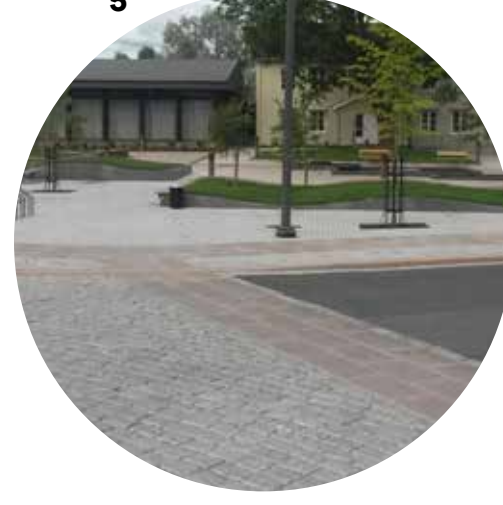
Fig 139 Prinsens gate Opphøyd bred overgang med storgatestein og heller i oppramping
