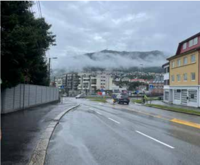
Fig 25 Bilveien og reguleringslomme for buss utgjør en bred barriere
