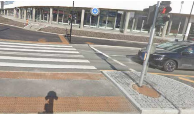
Fig 86 Gangfelt med sebrastriper. Taktile merking utført i støpejern.
