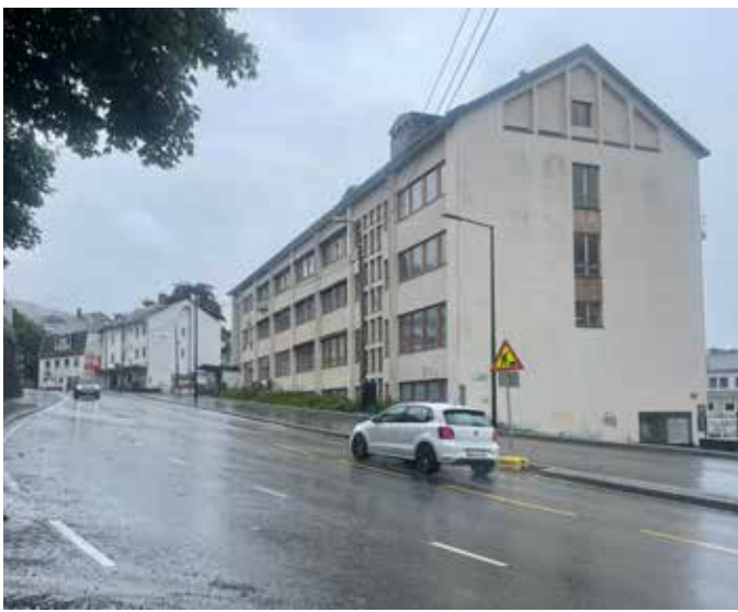
Fig 10 Administrasjonsbygningen nord på Meieritomten. Bygningen skal bevares.
