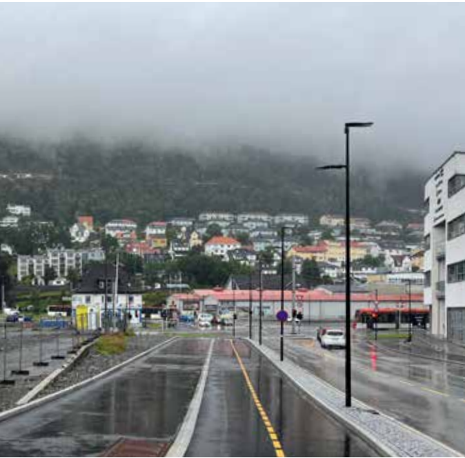
Fig 30 Eksisterende sykkelveg med fortau i Minde allé ned mot Kanalveien. Hovedsystem.
