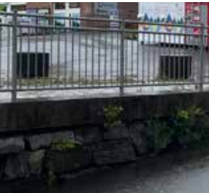
Fig 54 Natursteinsmur og gjerde
