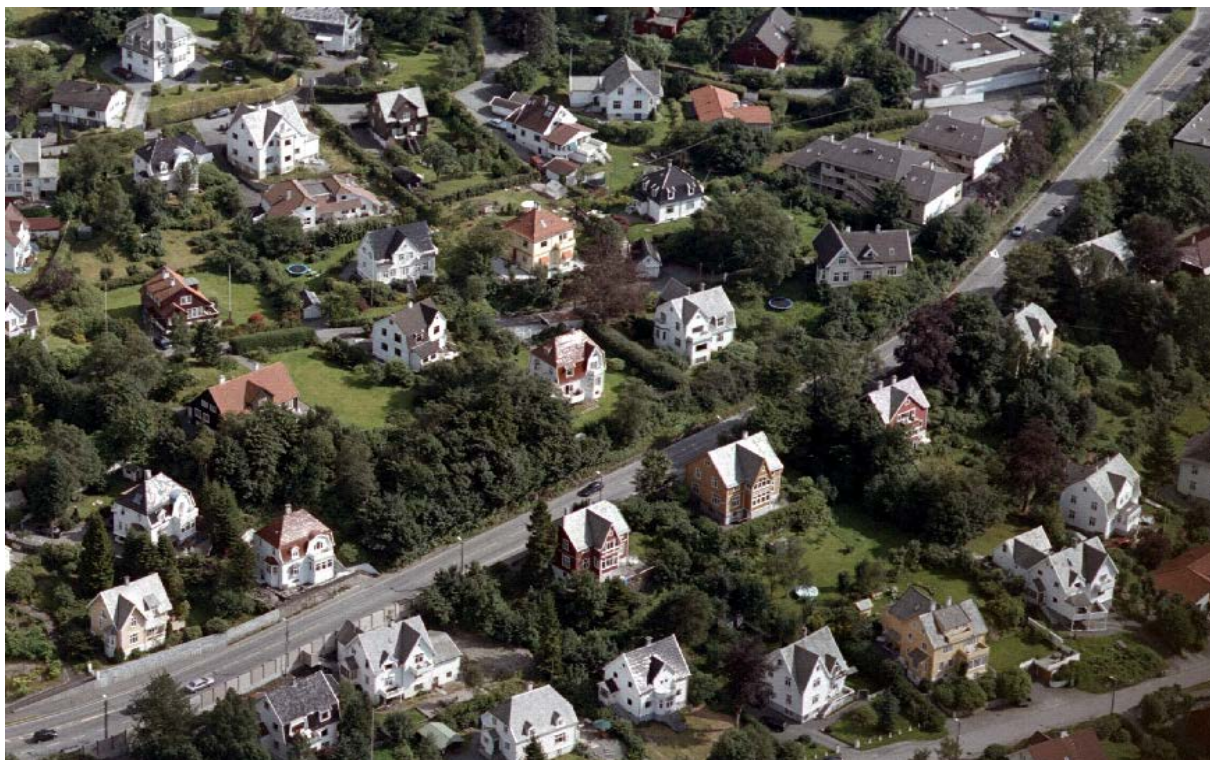
Storetveitsvegen på Wergeland (Bergen Kommune)
