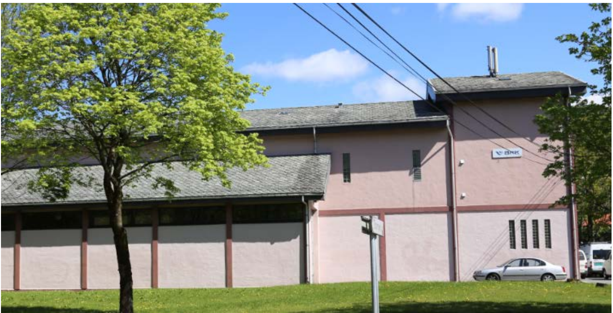
Storetveitvegen 84, Sekundærstasjonen i dag med senere tilbygg.
