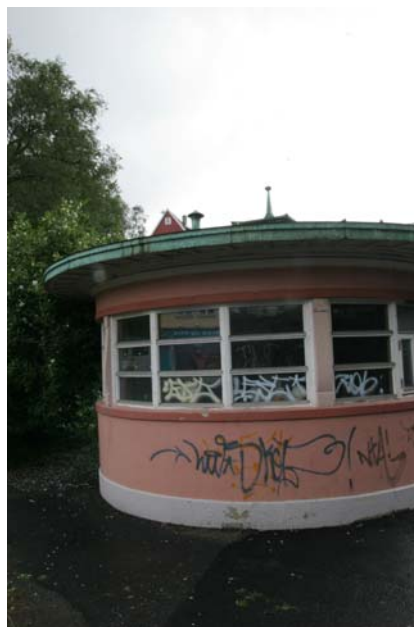
Sporveiskiosken sett fra nord
