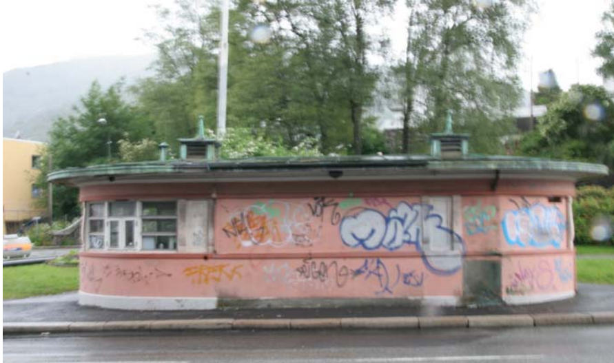
Sporveiskiosken, fasade mot Inndalsveien
