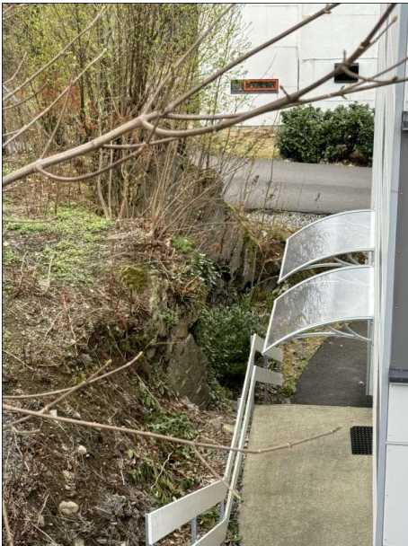
Bildet tatt ved Storetveitvegen 39, i sør
