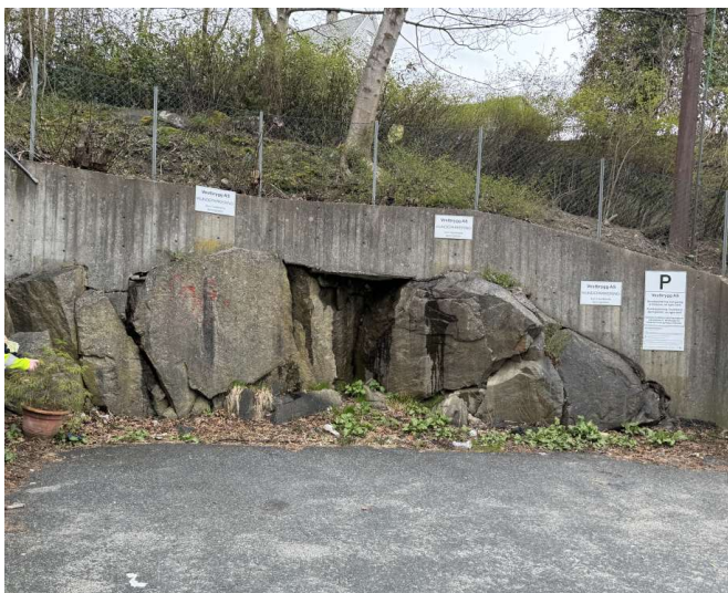
Bildet tatt ved Eikeveien 1
