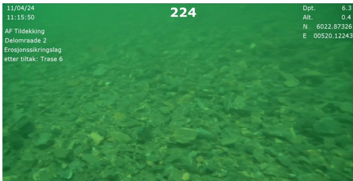
Figur 34 Bilde fra ROV-dokumentasjon av erosjonssikringslaget i delfelt 2B.
