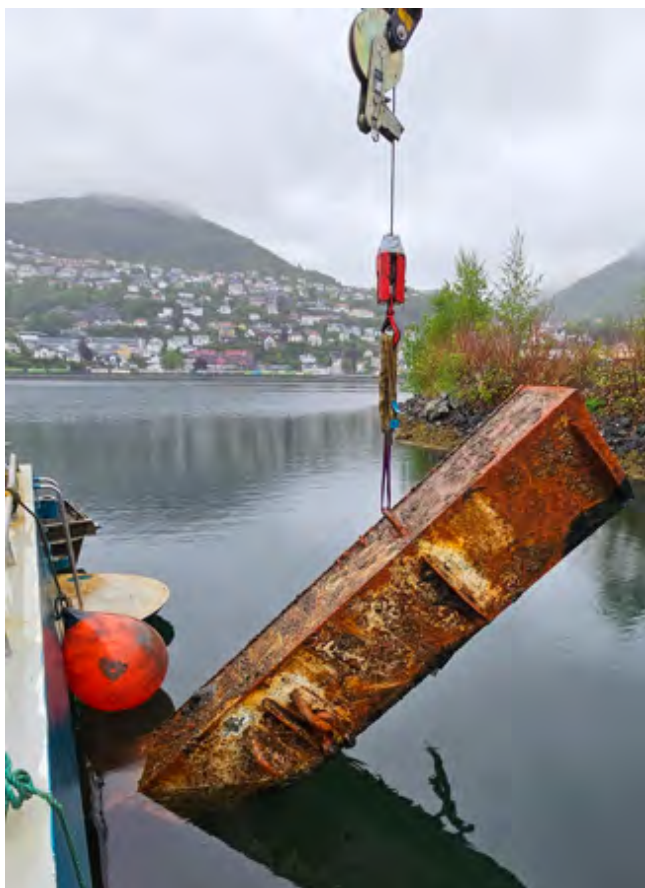
Bilde 3. Stålstruktur som ble fjernet.
