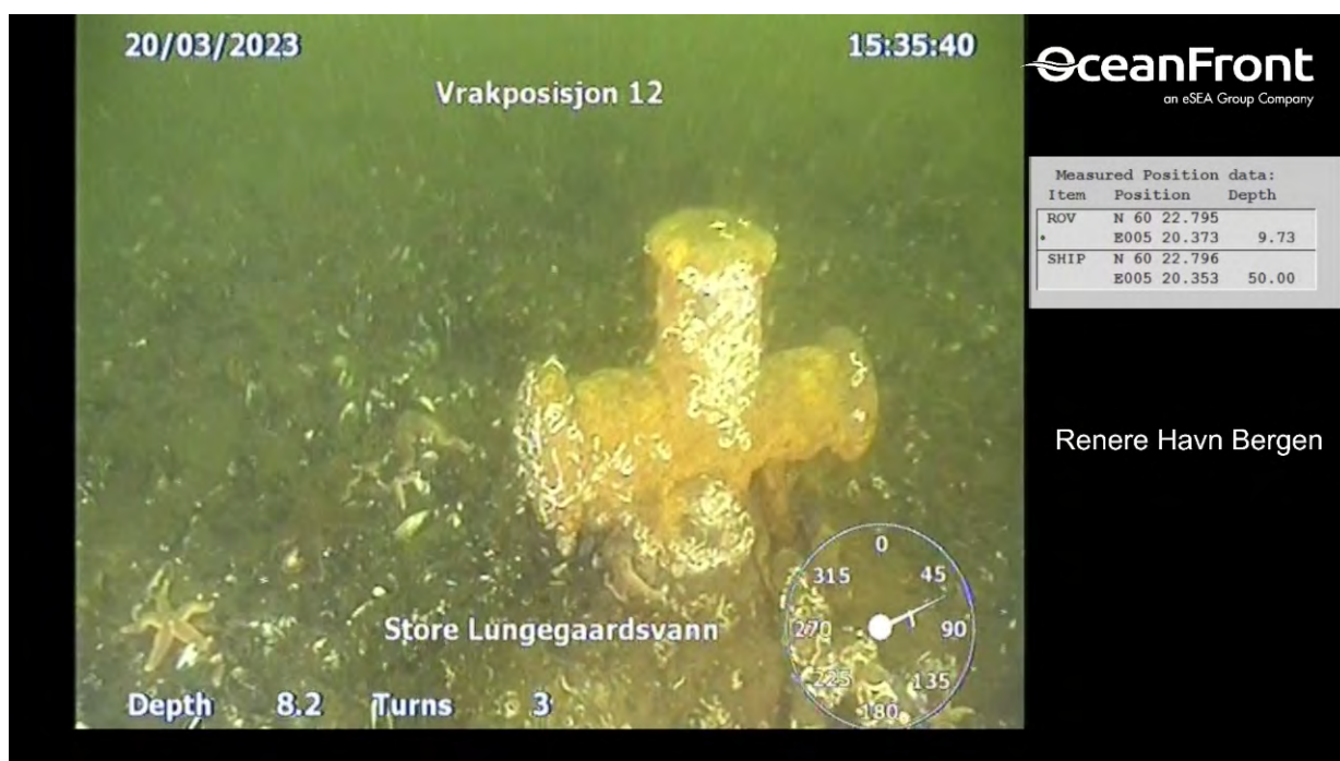
Figur 16. Fortøyningsgods på betongbrygge. Det er feil vraknummerering i bildet pga feil i grunnlagskart. I denne rapporten er objektet nummerert som 21.
