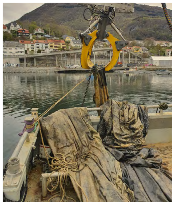
Bilde 4. Deler av silt-gardiner blir fjernet
