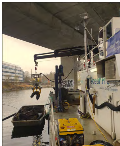
Bilde 2. Arbeid under Nygårdstroen
