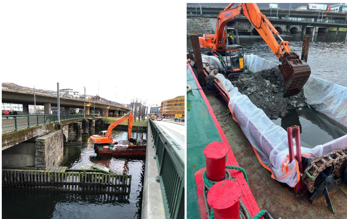
Figur 4 Bilder fra mudringen (venstre) og omlasting fra gravelekter til større lekter (høyre)
