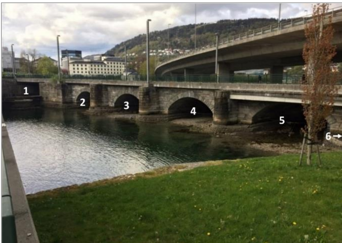
Figur 2 Gamle Nygårdsbro og løpene under broen nummerert fra 1-6, der løp 1 er det farbare løpet på nordsiden av broen. Bildet er tatt før tiltak ved springfjære (svært lav vannstand).
