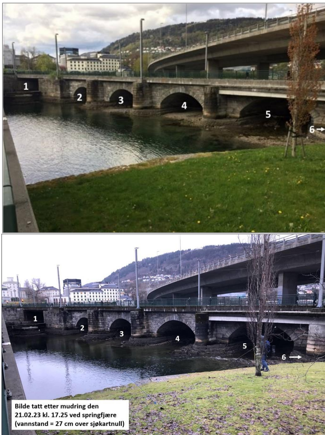
Figur 9 Bilde av Gamle Nygårdsbro tatt før (over) og etter (under) mudringen ved springfjære. Etter mudring ved springfjære er det vanngjennomstrømning i løp 2-5 der det tidligere var tørrlagt land.
