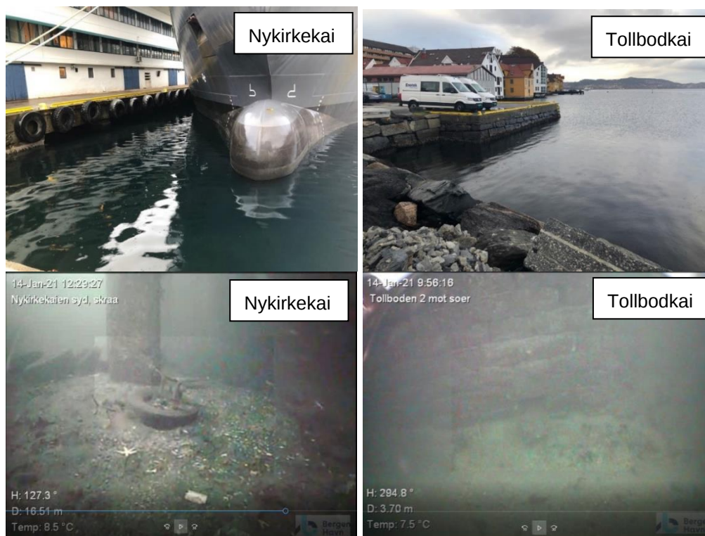
Figur 9 Nykirkekai står på peler (venstre) mens Tollbodkai har murt front (høyre) (kilde: ROV-undersøkelse utført av Bergen Havn, januar 2021).
