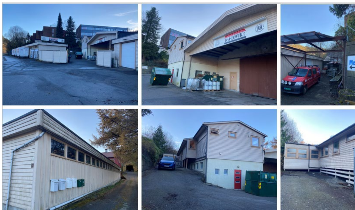
Figur 15: Bilder av bygget på gnr. 124, bnr. 356 (Kulturminnedokumentasjon datert)
