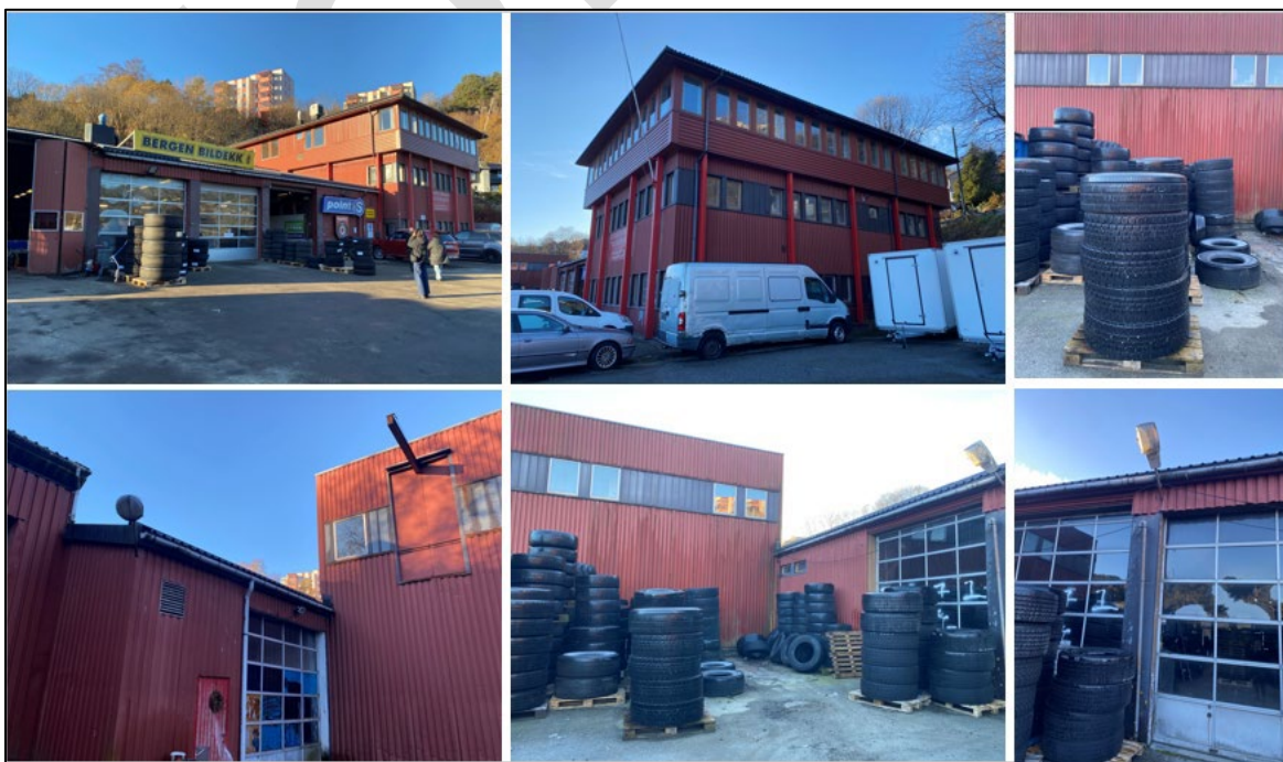
Figur 14: Bilder av bygget på gnr. 124, bnr. 52 (Kulturminnedokumentasjon datert 07.06.2024).
