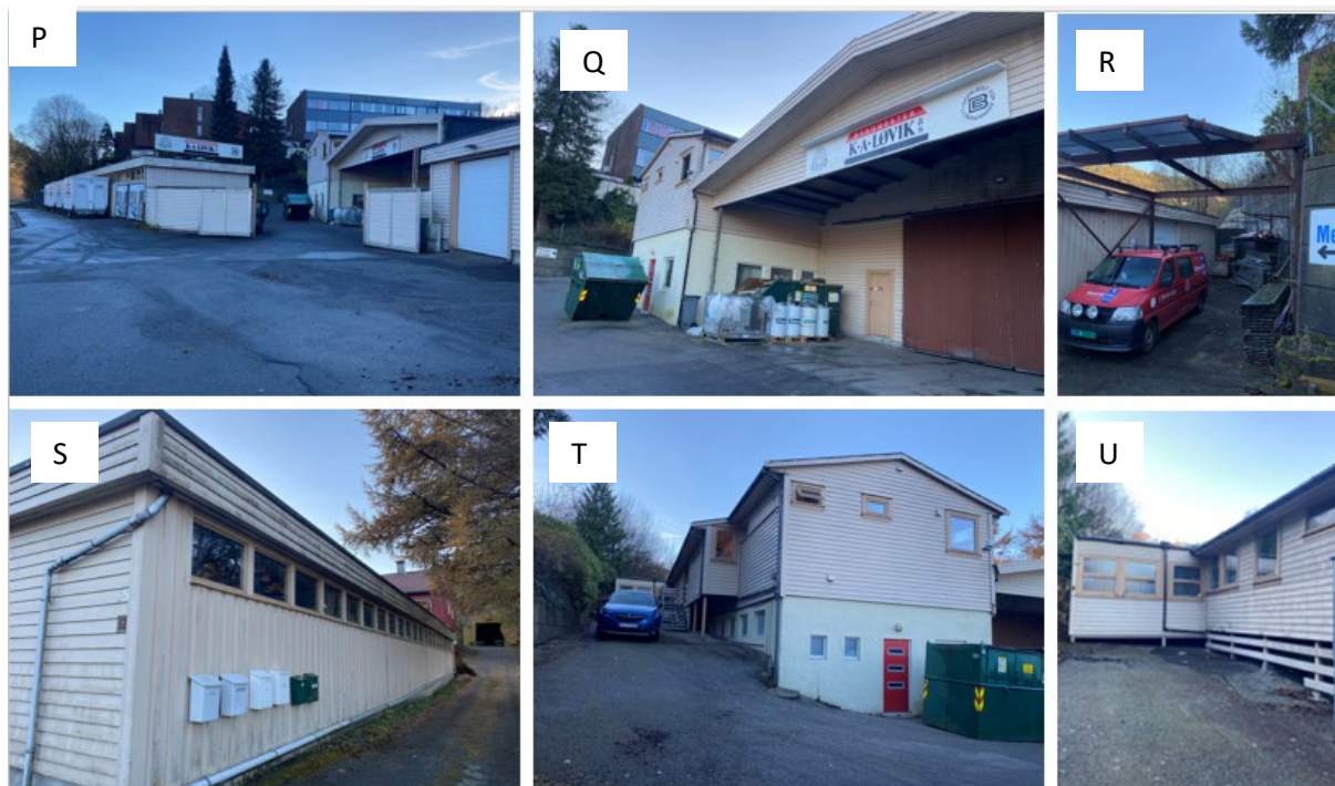
Figur 4-14 Hovedhuset på eiendommen er i dag innredet og brukt til kontor. Øvrig bygningsmasse benyttes til lager og verksted. Nummering viser til fotostandpunkt, se oversikt på kart bakerst.
