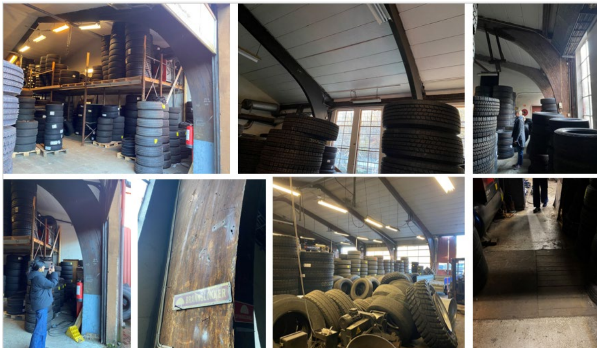
Figur 4-3 I verkstedhallen er den frittstående laminerte bukonstruksjonen fortsatt godt synlig. På bildet nederst til høyre ses trolig et lokk lagt over en nedsenket del av den opprinnelige smørehallen.
