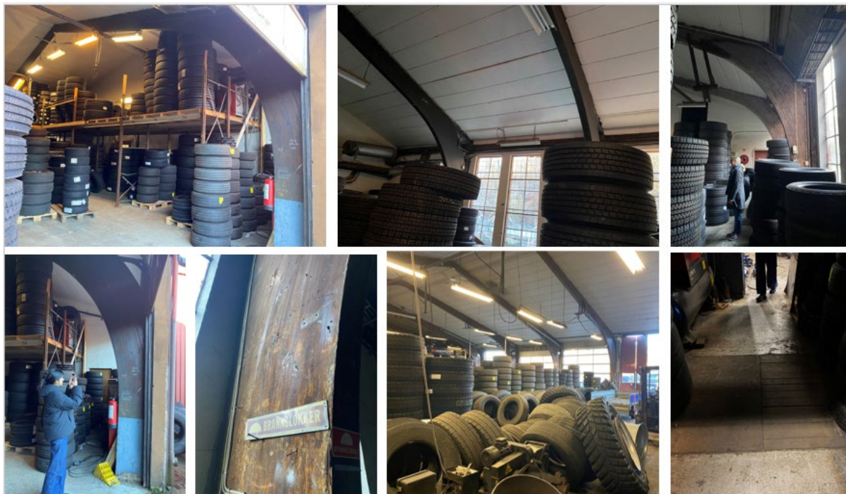
Figur 4-3 I verkstedhallen er den frittstående laminerte buekonstruksjonen fortsatt godt synlig. På bildet nederst til høyre ses trolig et lokk lagt over en nedsenket del av den opprinnelige smørehallen.
