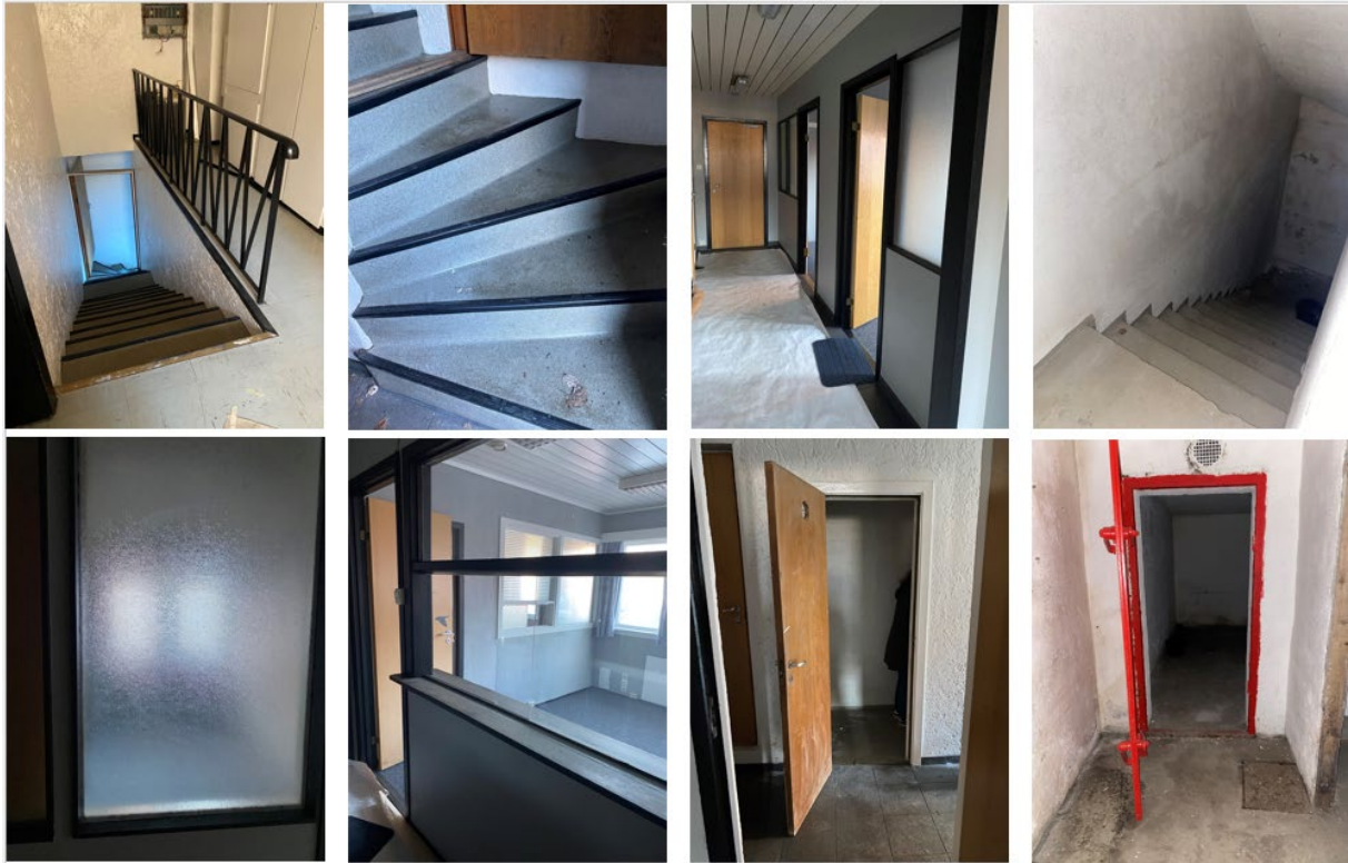
Figur 4-5 Detaljer fra interiøret i administrasjonsbyggets kjeller, 1. etasje og trapp opp til 2. etasje.
