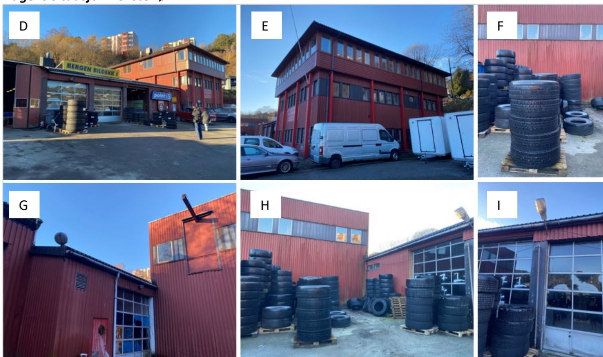
Figur 4-1 Fremfasaden av Haakonsvernveien er preget av ombygninger og moderniseringer utført fra anlegget stod ferdig i 1964 til siste påbygning i 1986. Nummering viser til fotostandpunkt, se oversikt på kart bakerst.
