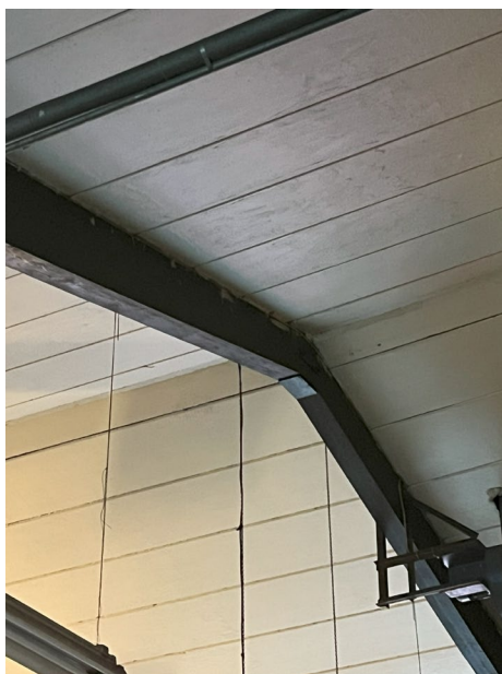
Opprinnelig takkonstruksjon over limtretragere
