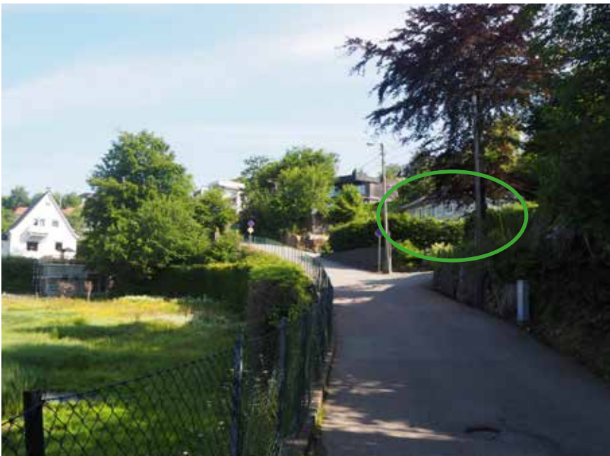
Planområdet med omgjevnader. Til høgre kan ein så vidt sjå Jacob Kjødes veg 16. I midten av bildet skimtar ein dei to nye leilegheitskompleksa som er bygd i 2013 og 2016. Heilt til venstre i bildet ser ein ein eldre villa frå 1920, med stiltrekk frå eldre bergensk byggeskikk. Villaen har adresse Jacob Kjødes veg 19. Bildet er tatt langs Jacob Kjødes veg frå sør.
