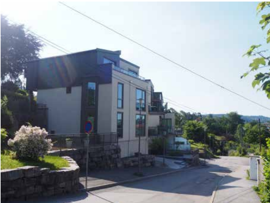
Det andre nybygget langs Jacob Kjødes veg, like nord for planområdet, med adresse Jacob Kjødes veg 8. Bygget stod ferdig i 2013.
