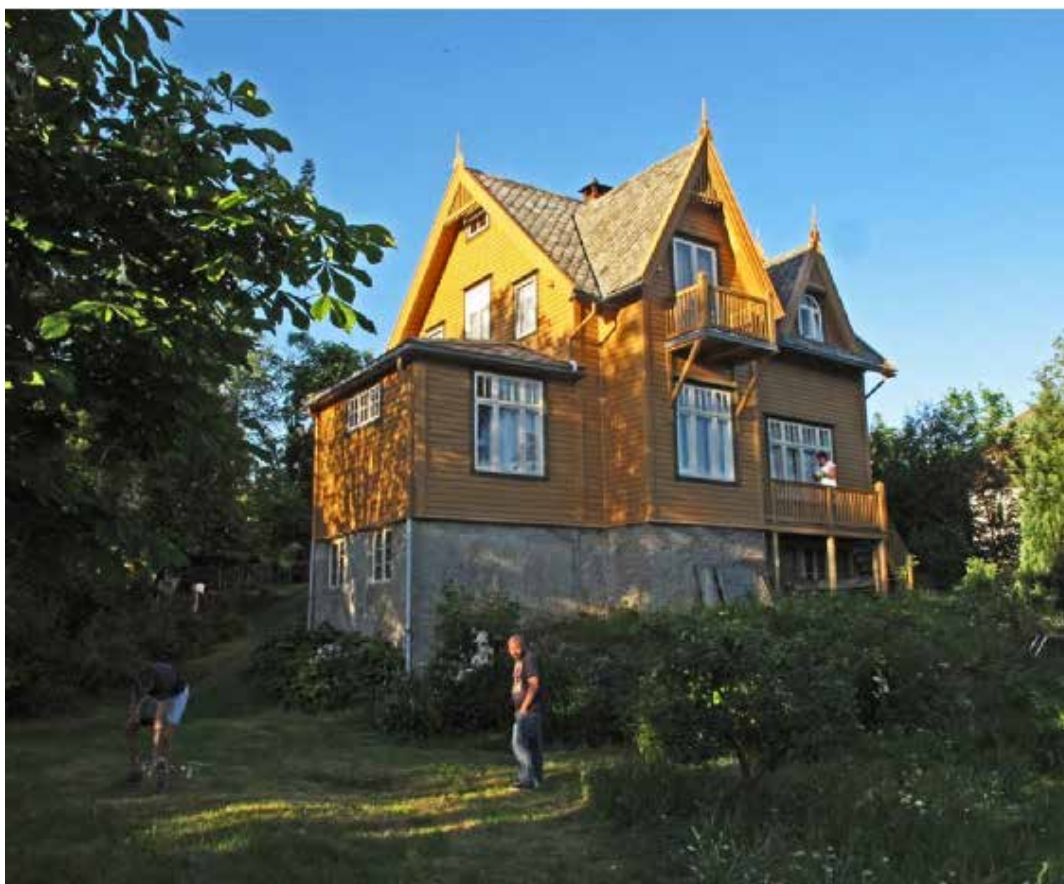
Villa Fagerlien i Mosebakken 9 med omkringliggende hage. Fasadar mot sørves og nordvest. Eigar opplyser om at det er så nær som ingenting igjen av det opphavslege hageanlegget. Foto: Øyvind Johnsen (2015) – Bygg og Bevar – https://www.byggogbevar.no/pusse-opp/inspirasjonsartikler/sveitserhus-paradis
